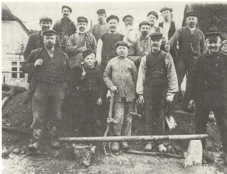
Selv om vandværket blev taget i brug i 1904, var det ikke ensbetydende med, at alle huse fik indlagt vand med det samme. Dette fotografi viser et hold arbejdere, der er ved at indlægge vand i Bondebyen i 1916. På billedet ses helt til venstre gas- og vandmester Andreas Malmgreen med sønnen Ludvig, og bag ham broderen, anboringsmester Holger Malmgreen.
