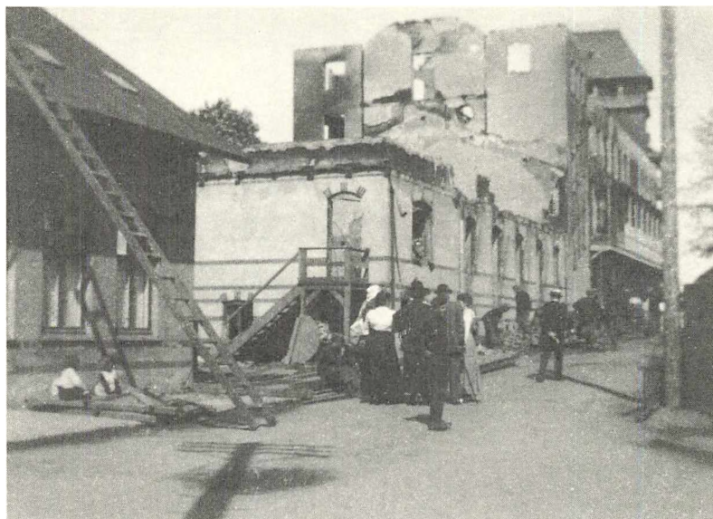
Den ødelagte hotelfløj langs Skovvej efter branden den 27. maj 1918. Helt til venstre ses den endnu eksisterende bygning Skovvej 8, nu kaldt Taarbæksdal. Byhistorisk Samling
