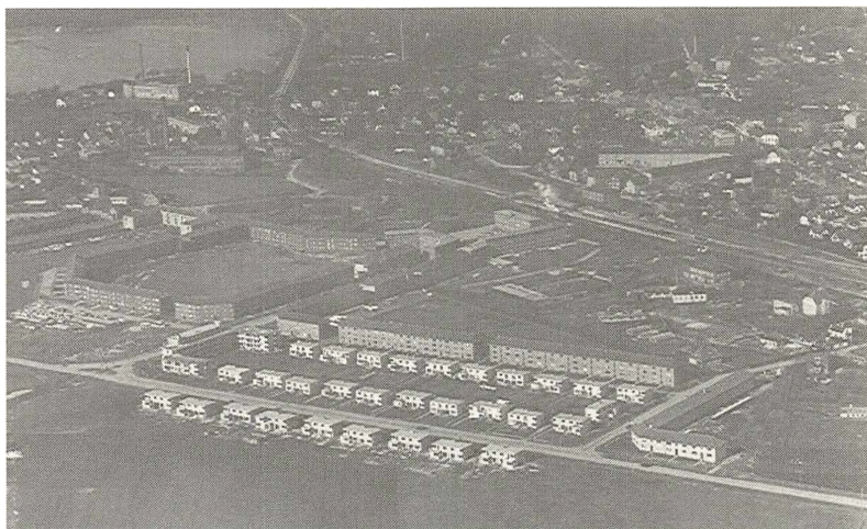
Etagebyggeriet på de kommunale Ulrikkenborgjorder foregik i 1930'erne efter en samlet byplan. Forrest ses de 39 dobbelthuse i »Den engelske Haveby«, i midten randbebyggelserne omkring de store parker og boligblokkene omkring den nye Ulrikkenborg Plads. I baggrunden Lyngby Torv, endnu uden Rådhuset. Foto 1936. Byhistorisk Samling
