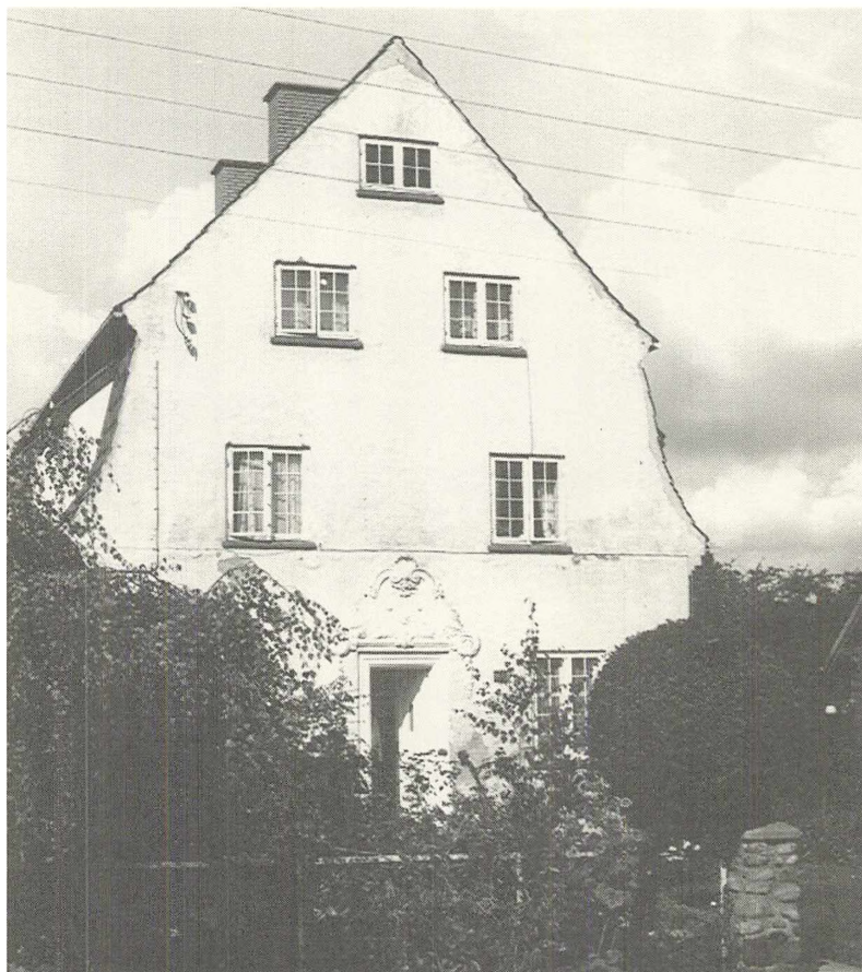
Den gamle filantropiske organisation »Lyngby Sogns velgørende Forening« opførte i 1920 huset Gammel Bagsværdvej 14E (»Aldersly 1920«, arkitekt P. Ulstrup Hansen, foto 1990). Staten og kommunen dækkede 30% af omkostningerne gennem et direkte tilskud. Sammenlign grundplanen (i byggesagen) med kommunens ældreboliger side 129.
