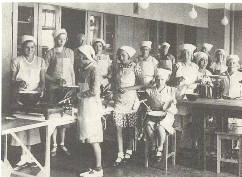
Udbygningen af boligkvartererne nødvendiggjorde bl.a. opførelse af nye skolebygninger. I 1933 åbnedes Lindegårdsskolens første halvdel, hvorfra dette billede af skolekøkkenet stammer. Lindegårdsskolen
