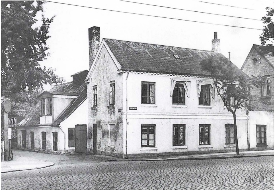
Malmgreens Smedie, Lyngby Hovedgade 39 på hjørnet af Gasværksvej. Både beboelseshuset ud til Hovedgaden og smedien langs Gasværksvej var opført i 1877. Bygningerne blev revet ned i 1959, da ejendommen på hjørnet af Klampenborgvej skulle udvides.
