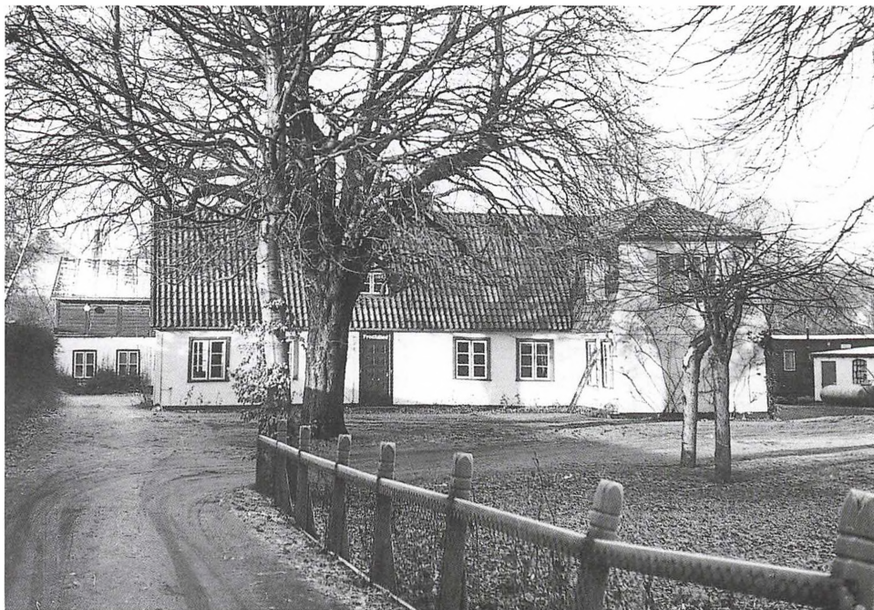
Ejendommen Fredlighed lå lige uden for kirkegården på nordsiden. De gamle bygninger fra 1867, som ses på billedet, blev revet ned i 1971. Den bageste bygning med jalousierne til tørreloftet foroven indeholdt Landvaskeriet Fredlighed. Ude af billedet til højre ligger det nye stuehus fra 1924, som i dag anvendes af den kommunale dagpleje i Lyngby-Taarbæk.
