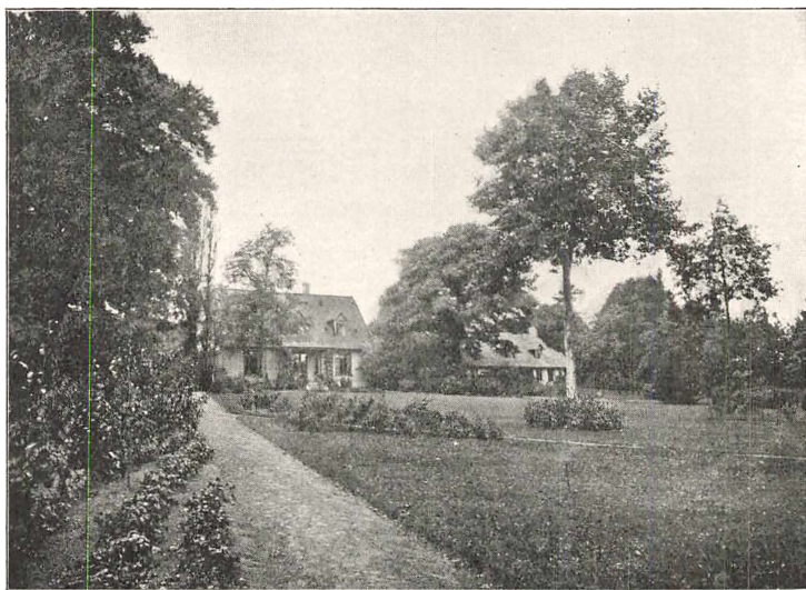
Skovgaard før Ombygningen.
