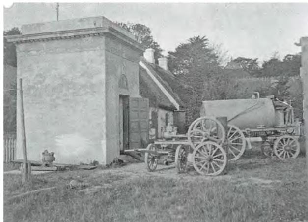
Kloakeringen af Taarbæk begyndte i 1881 og afsluttedes i 1918 med bl.a. en pumpestation, der pumpede vandet fra kloakkerne i den sydligste del af Taarbæk ud i Øresund. Til højre for bygningen ses materiel til tømning af septictanke. De to stråtekte huse bag pumpestationen er de nu nedrevne sidehuse til Villa Maud (Taarbæk Strandvej 42). Hen over taget af nr. 44 anes toppen af Koncertsalen på Klampenborg Badeanstalt.
