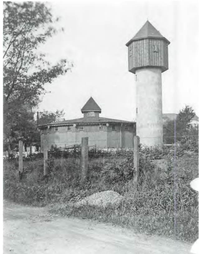
Både Lyngby og Taarbæk fik vand fra Lyngby Vandværk, da det åbnede i 1903. De første boringer skete i Sorgenfri Slotspark (herover), og det første vandtårn opførtes ved Fortunen i form af en tank, der stod direkte på jorden (til højre). Det lille ekstra vandtårn til højre opførtes i 1923 for at sikre vandtrykket i de omkringliggende ejendomme.
