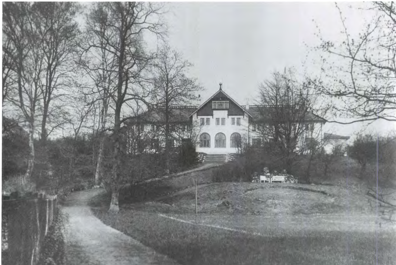
Grundtvigs Højskole tog sig imponerende ud, når man så den fra sydøst, altså set fra Mølleåen op imod hovedbygningens bagfacade. Fotografiet er fra før 1928, hvor det tidligere landbrugsmuseum brændte (dets tag anes yderst i billedets venstre side). (Lyngby-Taarbæk Stadsarkiv).
