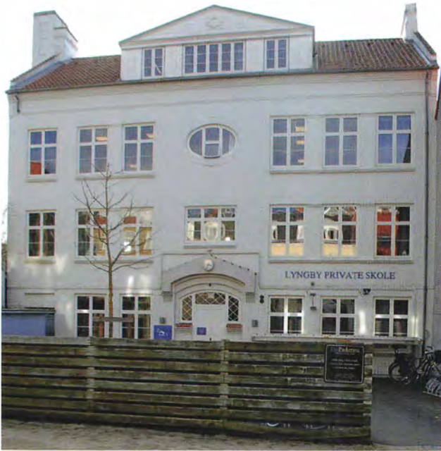
Da Lyngby Statsskoles nye bygning på hjørnet af Buddingevej og Chr. X's Allé blev taget i brug, blev gymnasieklassernes lokaler i Lyngby Realskole (Lyngby Hovedgade 56) ledige. Under- og mellemskolen med realklasse fortsatte som Lyngby Private Skole, men i skolebygningen i gården, der er opført i 1901, blev stueetagen indrettet til at rumme Lyngby Bibliotek. (Jepe Tønsberg foto).
