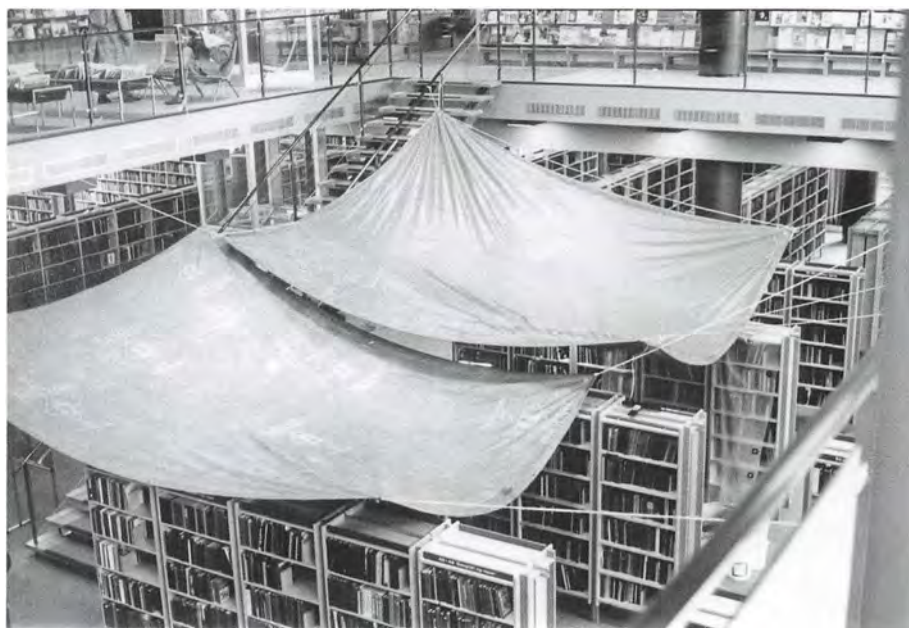
Omkring 1980 blev Stadsbibliotekets flade tag utæt, så der dryppede regn ned i biblioteket. I udlånssalen måtte man sætte presenninger op for at opsamle vandet og lede det ned i spande. (Jeppe Tønsberg foto).
