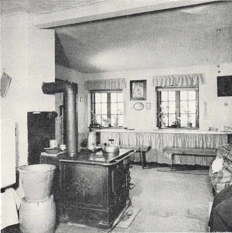
I gamle dage var der et meget stort komfur i kasernen, men idag, da der kun bor 3, er det erstattet af et mindre, men borde, bænke og cementgulvet er stadig det samme (1966).
