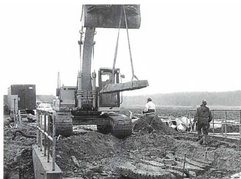
Fig. 6 Stenplankebroens dæksten fjernes og hejses op med maskinhjælp. Foto: Museet Falsters Minder.
