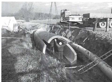
Fig. 8 Den nye betonbro erstatter den fjernede stenplankebro. Det sidste element løftes på plads med kranen. Det tog godt 2 timer at bygge denne bro; imens blev åens vand ledt gennem plastrørene til højre. Foto: Peter R. Svendsen, Broconsult A/S.
