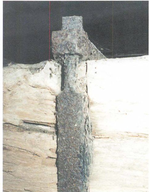
Jern har en stor styrke og var også brugt til sikring ved klokkestolens sammenhæng; men på langt sigt har jern den skavank, at det rustet og derved udvider sig kraftigt. Ved restaurering blev alle jernbeslag fjernet. De oprindelige tømrede samlinger blev atter gjort funktionsduelige.
