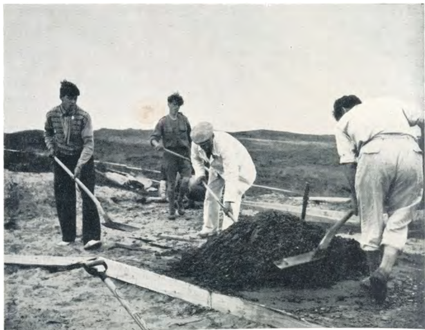
Der blandes mørtel til støbningen. Juni 1954.
