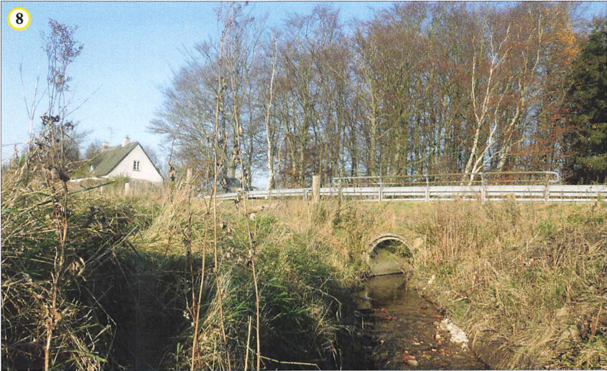
'Overkørslen ved Havegård': Antagelig et gammelt vadested, nu i form af en vejdamning hen over Øllemose Å, som er ledt gennem et cementrør under Møngevej mellem Vejby og Mønge. Foto: Lars Windfeld-Høeberg
