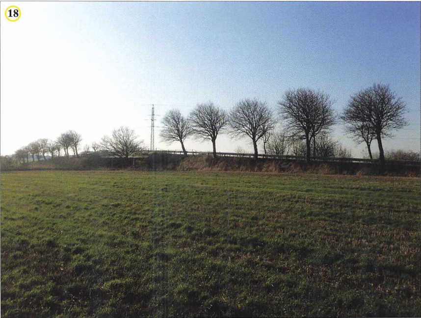
Viadukten af Farvergårdsvej mellem Orby og Vejby. Et elegant anlæg fra jernbetonbroernes barndom i midten af 1930-erne. Foto: Lars Windfeld-Hoeborg
