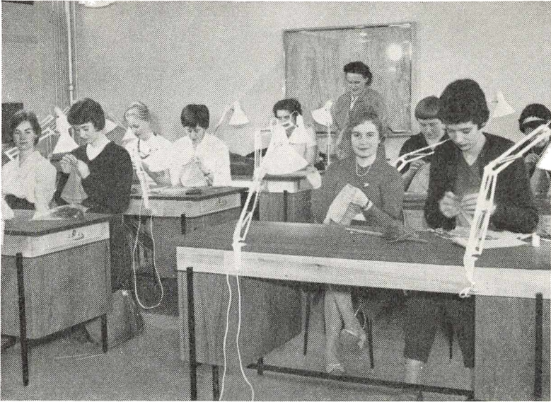
HANDGERNINGSKLASSE. Det er første gang, Jonstrup har haft et sådant lokale. Det er monteret med brede to-mandsborde, som hver rummer to elektriske symaskiner.
