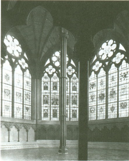
Gotik: Kapitelhuset i Westminster Abbey, London, fra 1245-53 har spidsbuer og ribbehvælv. Under vinduerne ses blændarkader.
