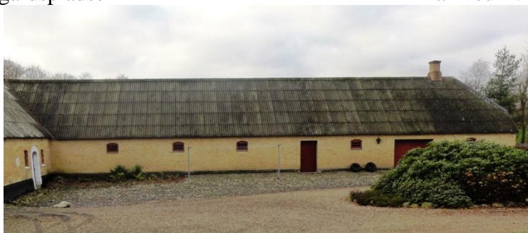
Avlsbygning til højre for stuehuset
