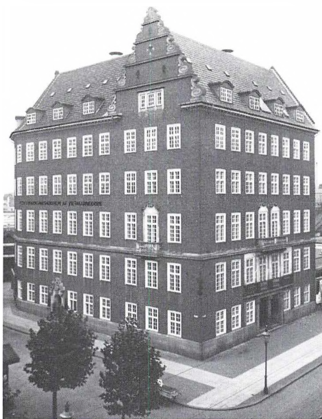
Forbundets hovedkontor havde 1916-72 domicil i denne ejendom på hjørnet af Gammel Kongevej og Vester Søgade i København. Ejendommen blev i 1938 udvidet med en tilbygning til venstre i billedet, hvor bl.a. de københavnske afdelinger fik til huse.
