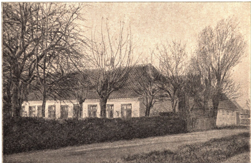
Gammelt Hus ved Vanløse Gadevej.
