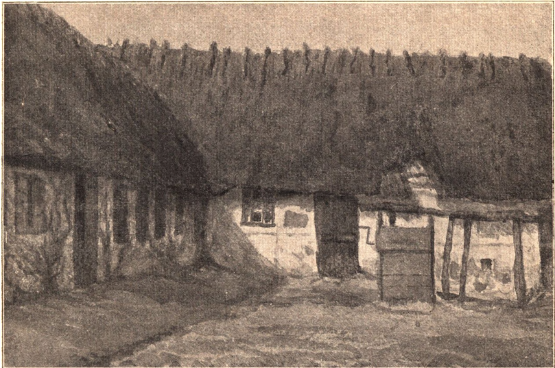
Den sidste Gaard fra Fællesskabets Tid i Vanløse By (nu ombygget; efter en Akvarel).
