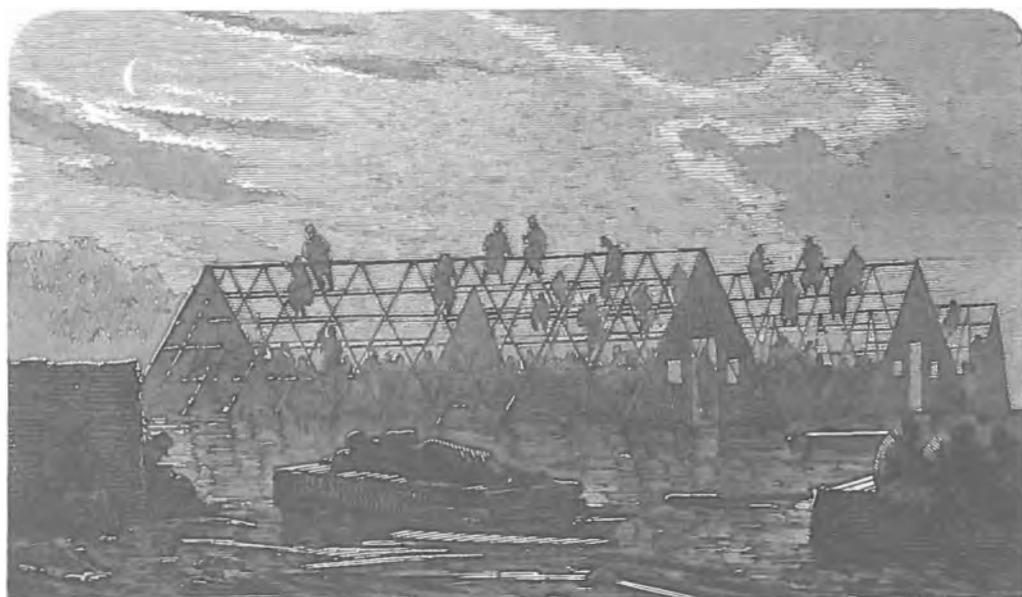
Kattelet på Røstene af de halvfærdige Skovhuse ved Danevirke.
