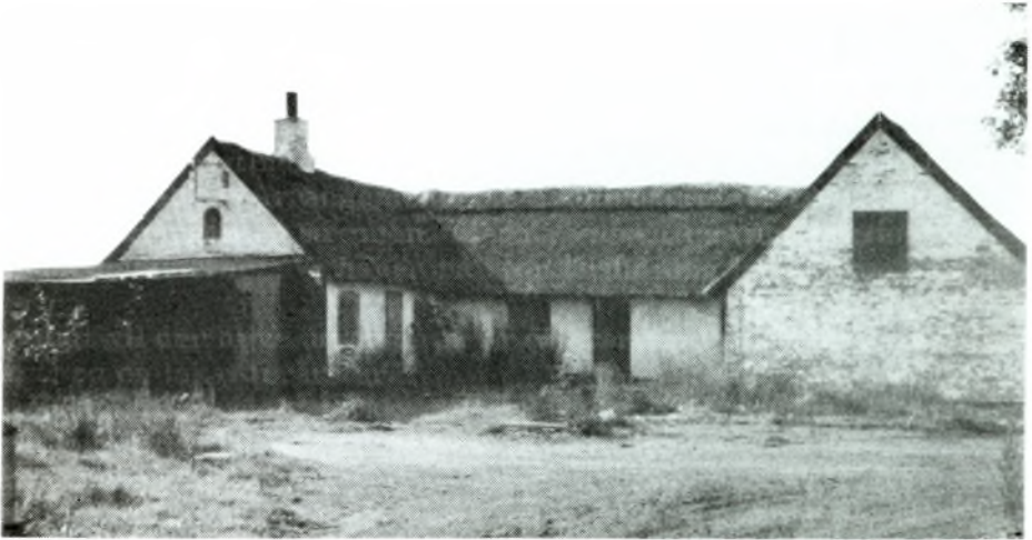
"Buhl-Olsens ejendom" ved Stormosevej blev nedrevet i 1974 ved Frugtvangens anlægelse.
