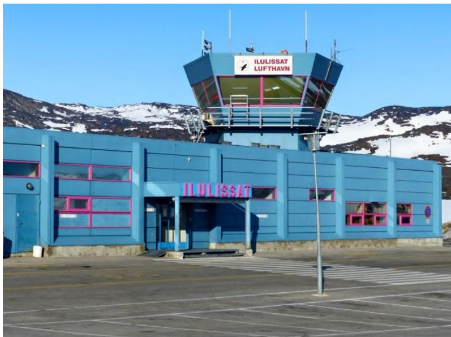
Lufthavnsbygningen i Ilulissat.
