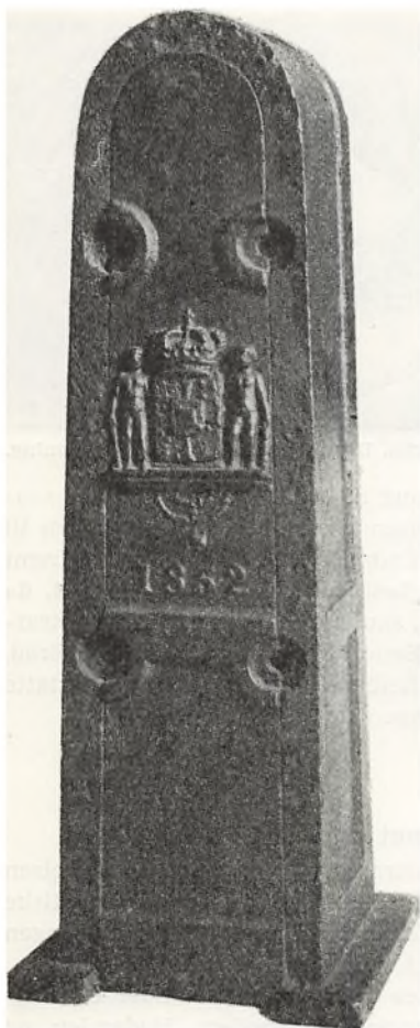
Støbejernsprøvekassen, som kablet blev ført op i med mellemrum, hørte til Øresundslinjens udsatte punkter.
