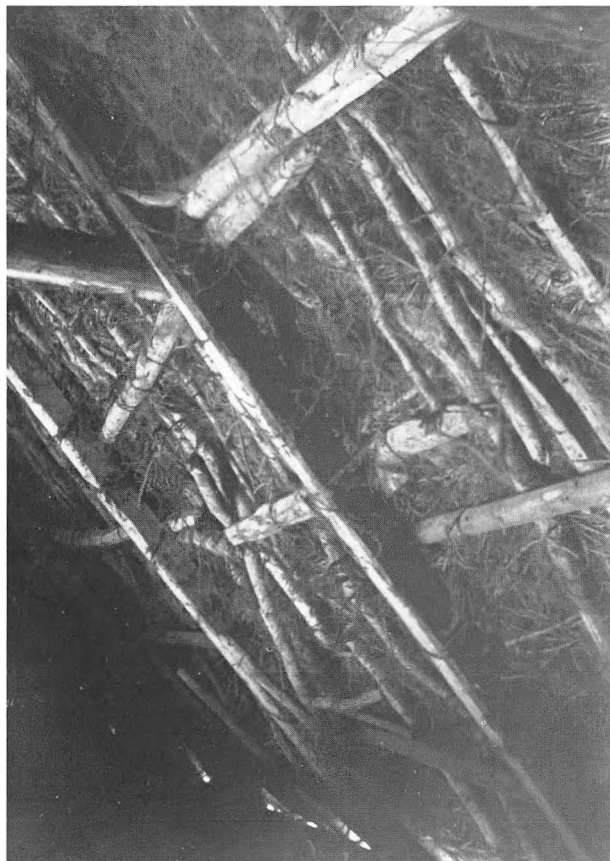
Fig. 32. Raftetag lagt på en slags uregelmæssigt anbragt sideås kunne fotografers før 1922 i Slaglille lige øst for Sorø.
