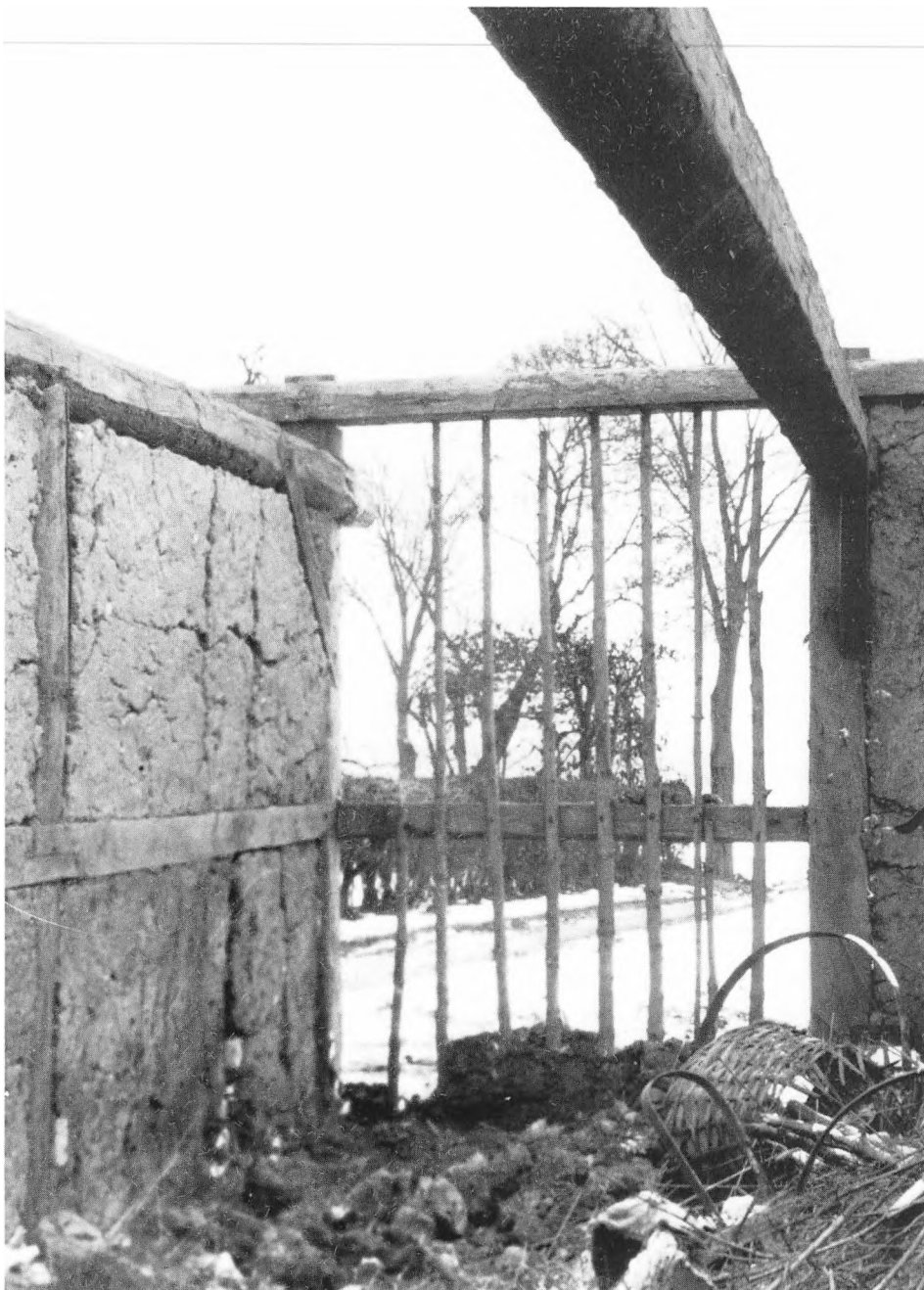
Fig. 11. På denne gård i Sonnerup ved Højby i Odsherred ses tydeligt, hvorledes forbindelsen mellem stolpe, bjælke, rem og spær har været udført i den enkle sidebåndskonstruktion. Det er karakteristisk, at spæret står som en klo ned om inderkanten af remmen, at denne ligger i en udskæring i den øverste ende af stolpen, mens bjælke og stolpe er skåret halvt i halvt, »glammet«, og er fastholdt med en svær trænagle. Den lille skalk på siden af spæret hviler mod remmens yderside.
