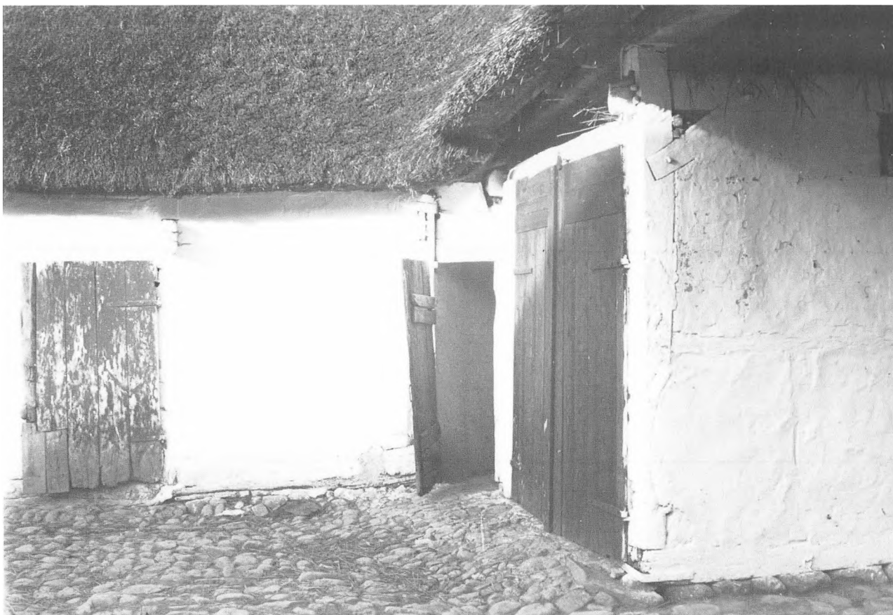
Fig. 37. Et hjørne i en gård i Vålse på Nordfalster. Her ses døre og porte til forskellige udhusrum. Bindingsværket er overkalket og er med gennemstukne bjælker, døroverligger, dukker og skråbånd i indkørselsportens vægtavl.
