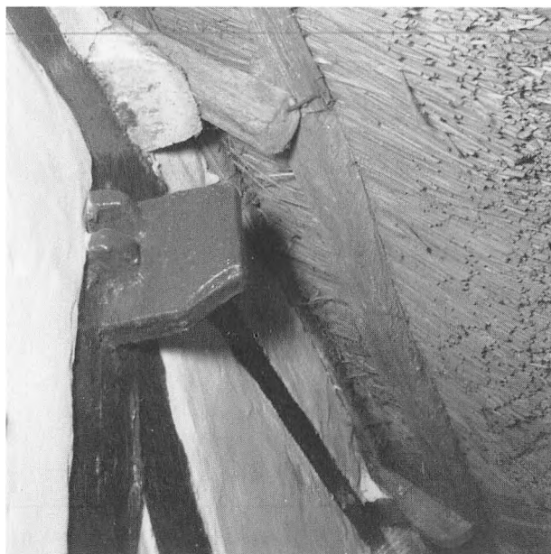
Fig. 53. Nærbillede af forbindelsen stolpe med gennemstukket bjælkehoved fæstnet med to trænegler. Herover remmen og spærenden med skalken, der fører nederste lægte og tagskæg ud fra lervæggen på en gård på Tåsinge.
