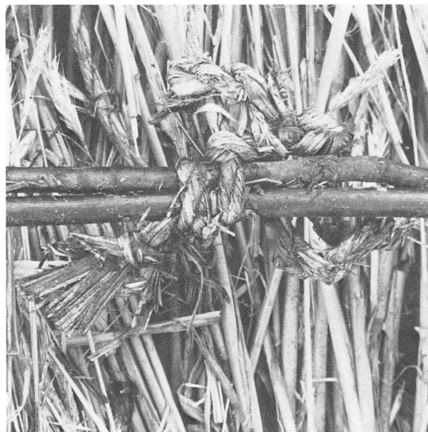
Fig. 24. Underside af stråta- get, der er påbundet lægterne med halmbånd.
