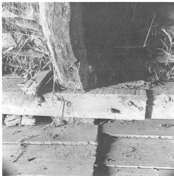
Fig. 73. Samling af spær og hanebånd v.hj.a. udskåret svalehaleblad, træagle og hage i stuehusets tagværk på tvillinggården i Stouby.
