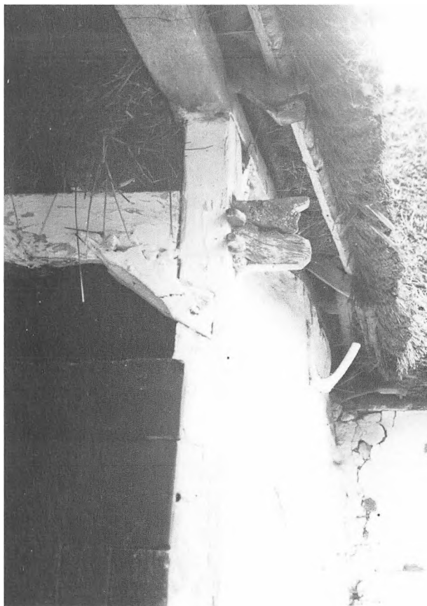
Fig. 41. Et lille skråbånd med svalehale og gotisk affasning forbinder stolpe og gennemstukken bjælke i portfaget på en gård i Nørre Ørlev. En naturvokset, tvejet krog er anbragt på den ene vægstolpe til ophængning af tøj, grimer o.lign.
