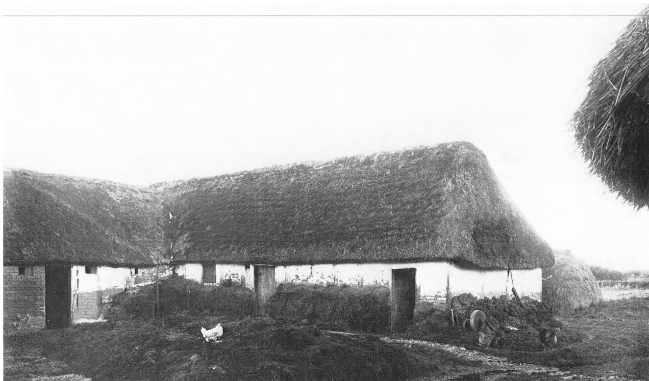
Fig. 71. Helvalm-taget på denne vestjyske gård ser »stri- bel« ud, fordi det er lagt op af skiftevis strå og lyng.
