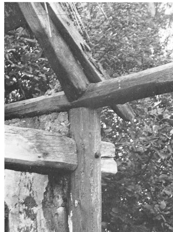
Fig. 11. På denne gård i Sonnerup ved Højby i Odsherred ses tydeligt, hvorledes forbindelsen mellem stolpe, bjælke, rem og spær har været udført i den enkle sidebåndskonstruktion. Det er karakteristisk, at spæret står som en klo ned om inderkanten af remmen, at denne ligger i en udskæring i den øverste ende af stolpen, mens bjælke og stolpe er skåret halvt i halvt, »glammet«, og er fastholdt med en svær trænagle. Den lille skalk på siden af spæret hviler mod remmens yderside.
