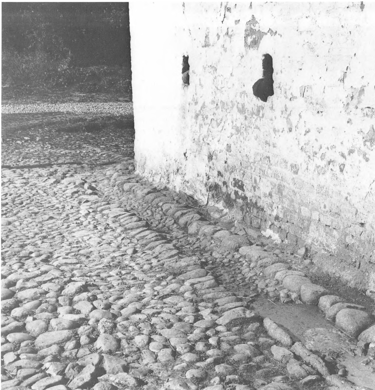
Fig. 88. På en gård sydøst for Esbjerg er der lavet en afløbsrende i brolægningen. Den går fra stuehuset langs østlængen til møddingen.
