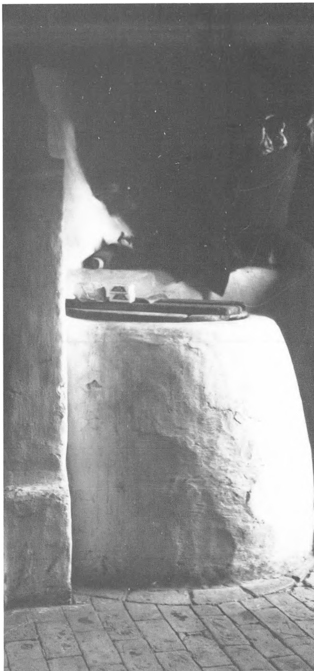
Fig. 55. Nærbillede af bryggerkedelen i tilslutning til den åbne skorstens ene vange i en gård på Bjørnø.
