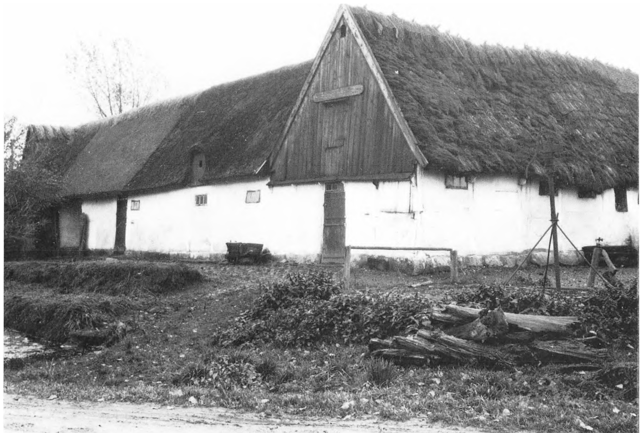
Fig. 4. Almindelig sjællandsk gård med spinkelt overkalket bindingværk med kraftig stensyld og med sammenbyggede længer. På de to sidelænger er der lodrette bræddegavle og kragetræer hen langs rygningen. Gård fra Tune.
