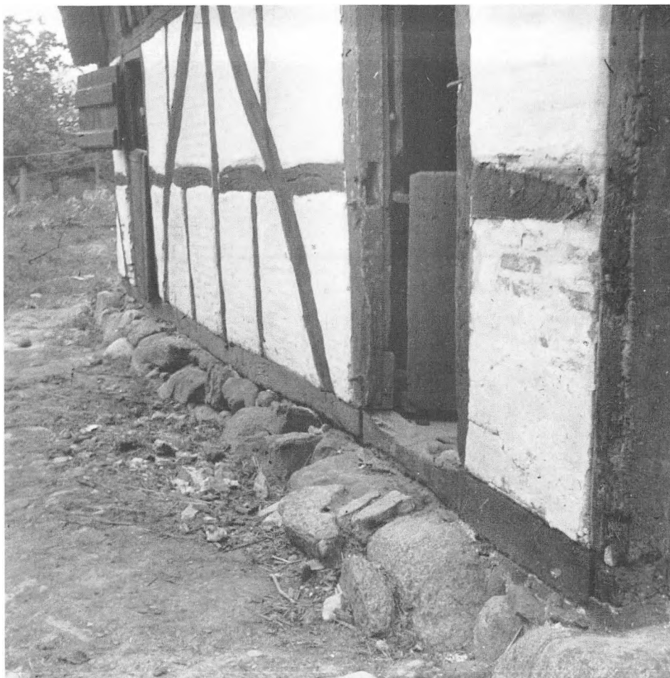
Fig. 51. Bindingsværket i en gård på Ærø. De to skråstivere, der begge hælder mod en stolpe midt i gavlen, viser, at gården er sulebygget. Fodremmen hviler på en høj, uregelmæssig stensyld.
