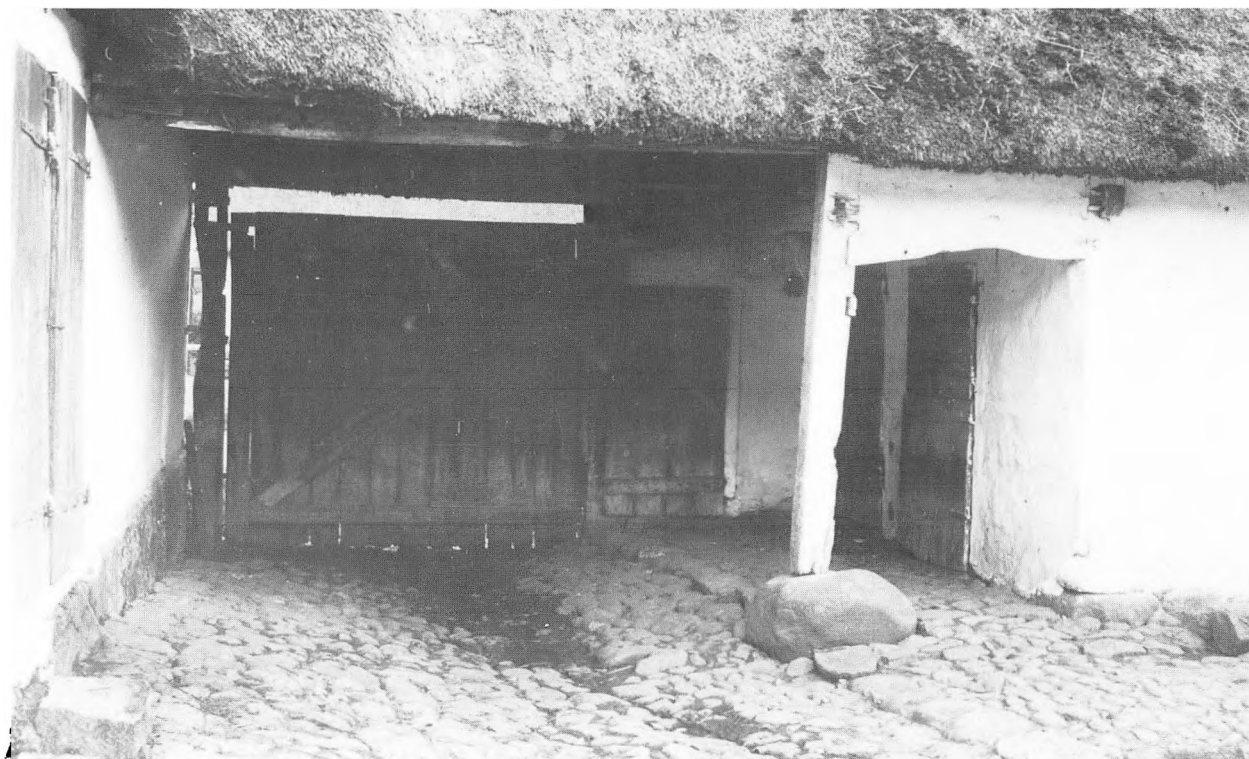
Fig. 21. Gadeporten i vestlængen i Kongsgården i Lejre. Den ses her inde fra gårdspladsen. I længen er et klime-taui fra 1786. I portens højre side findes den daglige gennemgang for gående trafik, således at porten kan holdes lukket for mindre husdyr, der kan gå frit omkring på gårdspladsen. Herfra er der afløb ud under porten.
