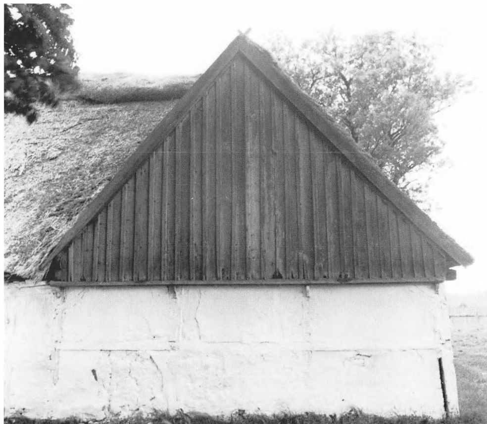
Fig. 9. En lodret bræddegavl med vindskeder, der afstutter tagfladen og vandbræt forinden for at beskytte lervæggen. Gavlens tre fag er hvidkalket bindingsværk med udvendige sidebånd af stenlægestørrelse. De er bladet på tværs af stolperne og fæstnet på hjørnestolperne med håndmedede søm. Små skråbånd, ligeså påbladet, forbinder de glammede bjælker med stolperne. Gården er typisk for Københavns-egnen og er fra Vallensbæk.
