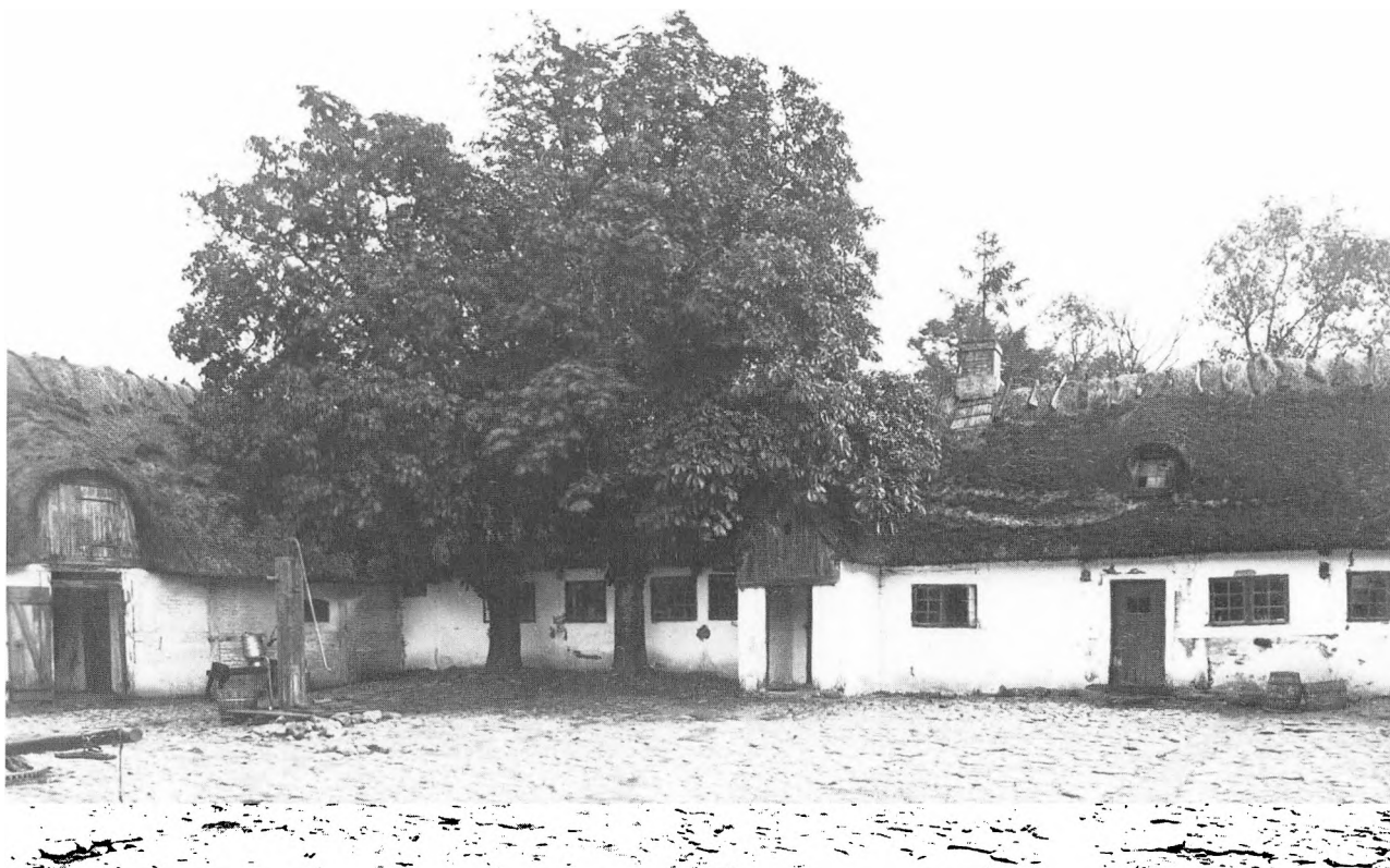
Fig. 16. »Kongsgården« i Lejre, mens udhuslængerne endnu var bevaret. Disse er af meget forskellig alder. Foran hovedindgangen i stuehuset ses et lille bislag med trægavl. Til højre for bislaget ses køkkenafdelingen med stuehusets skorsten, der er her meget svære egestolper med mærker efter flere tidligere anbringelser af udvendige sidebånd udover den nuværende. I resten af gården er anvendt almindeligt tappet bindingsværk, dog enkelte andre steder med spor efter den ældre sidebåndskonstruktion.
