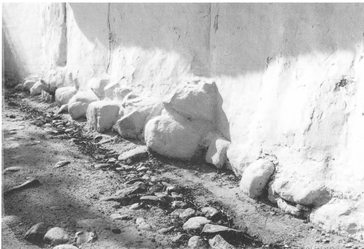
Fig. 6. Det ses tydeligt i stenbrolægningen, at tagdryppet ligger i passende afstand fra de skrøbelige lervægge. Den uregelmæssige kampestensyld under øsilængens østvæg støtter det spinkle bindingsværk, hvor både stolper og indvendige sidebånd ligger mere eller mindre skjult bag de hvidkalkede vægge. En gård i Ullerup, Amager.
