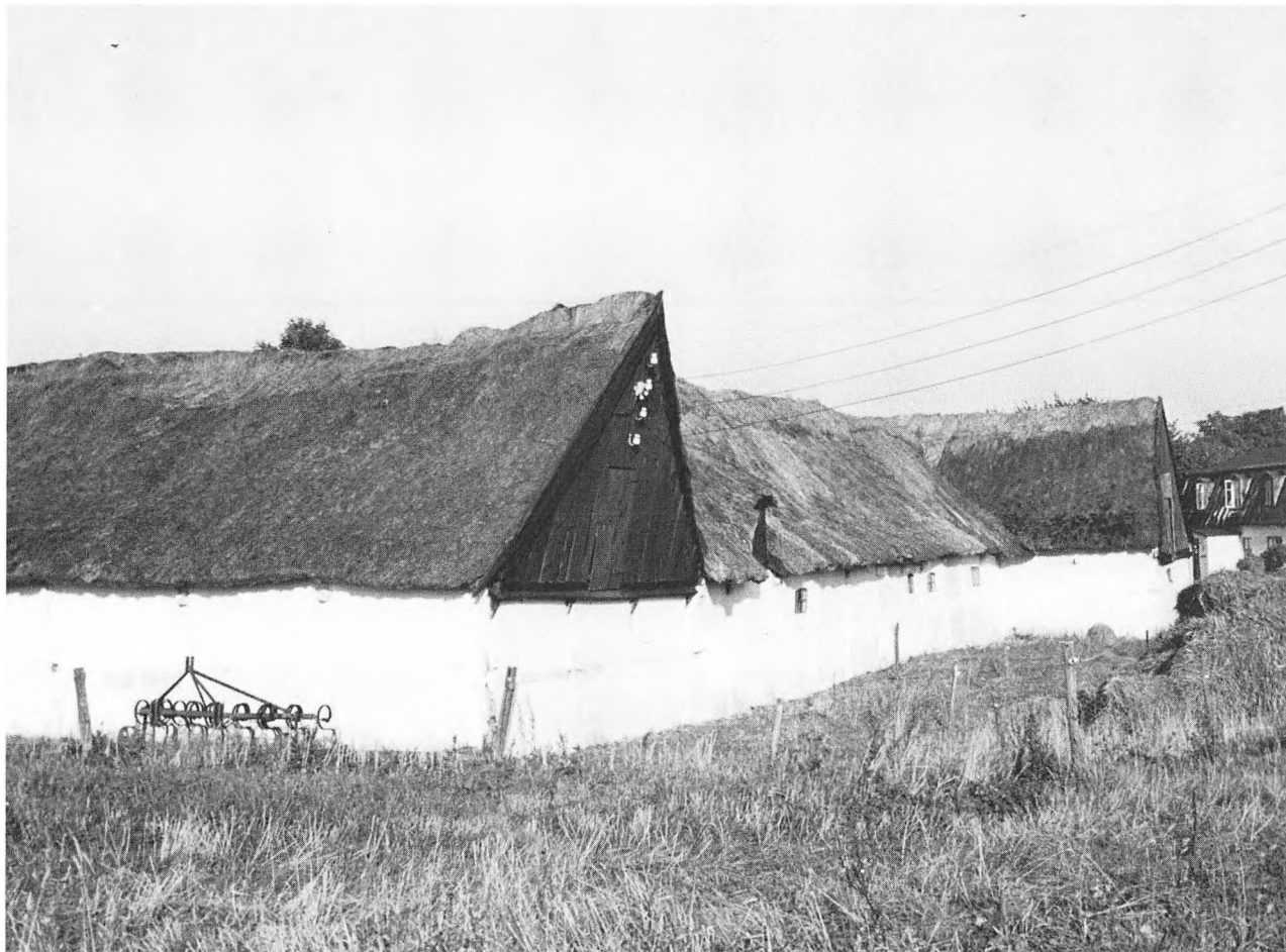
Fig. 27. Gammel gård, Abildgård, i Knapstrup stationsby. De fire længer er sammenbyggede, men har et par lodrette trægavle, og det overkalkede bindingsværk skjuler en udvendig sidebåndskonstruktion.
