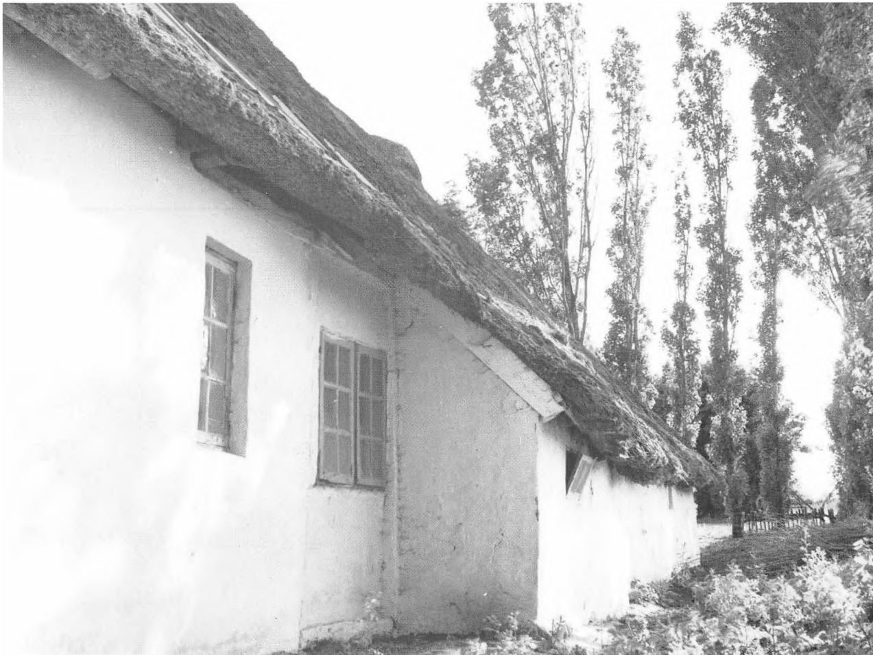
Fig. 42. På Askø var der, som det ofte ses på Lolland i ældre tid, beboelse og udhus i samme længe. Her er det 92 cm brede udskud langs nordsiden foran udhusparten med lo og lade. Længen er opført 1795.
