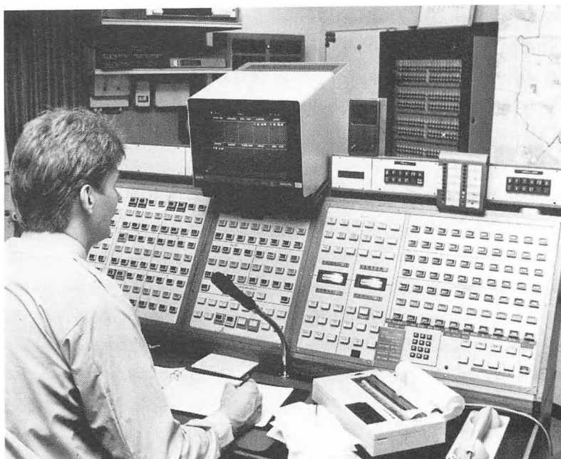
Fra alarmeringscentralen på Hovedbrandstationen.
