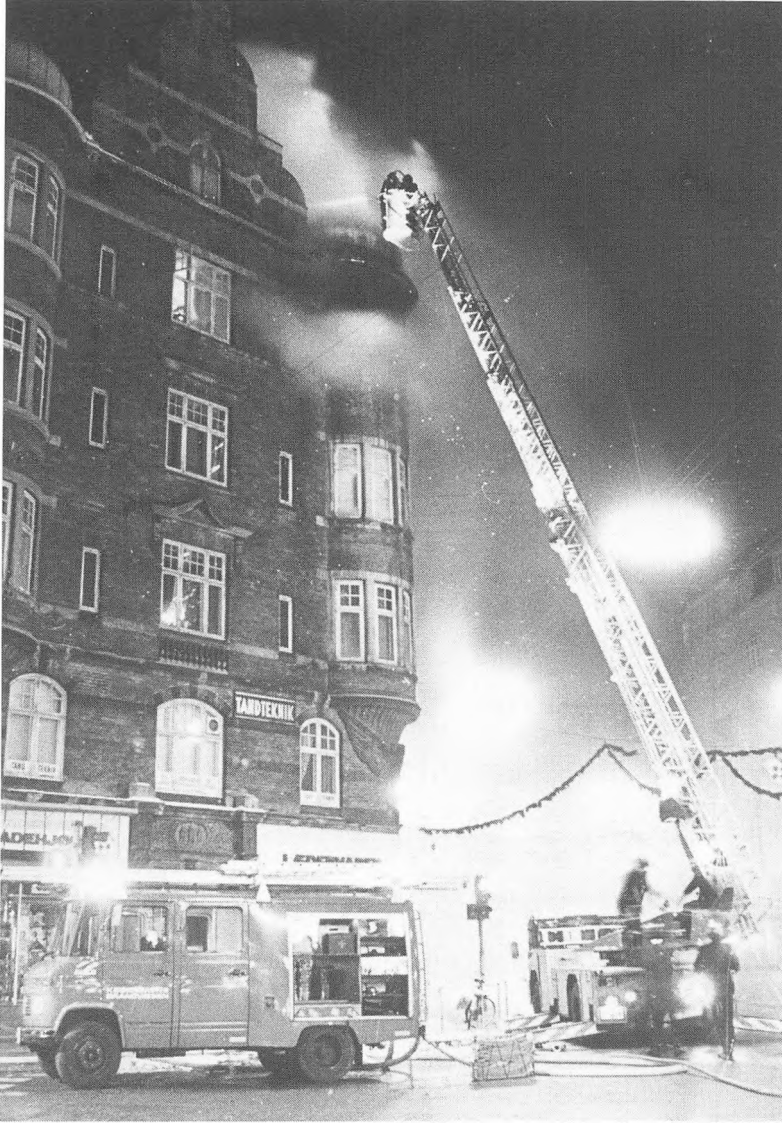
En tagbrand i december 1981 slukkes fra toppen af en stige.
