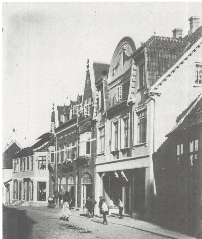
Billedet viser de nye ejendomme i Østergade nr. 26 og 28 samt nr. 30, med det skrå hjørnefag. Bag nr. 30 anes gavlen af den gamle bindingsværksgård, som blev nedrevet i 1911.
