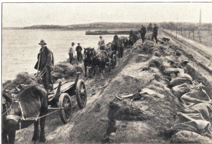
Istandsættelse af dæmningen efter stormfloden.
