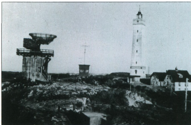
Würzburg Riese Radar ved Blåvand Fyr 1945. Den var drejelig og kunne med en rækkevidde på 50-60 km angive både retning, afstand og højde på et fjendtligt fly. Foto: Blåvandshuk Lokalhistoriske Arkiv.
