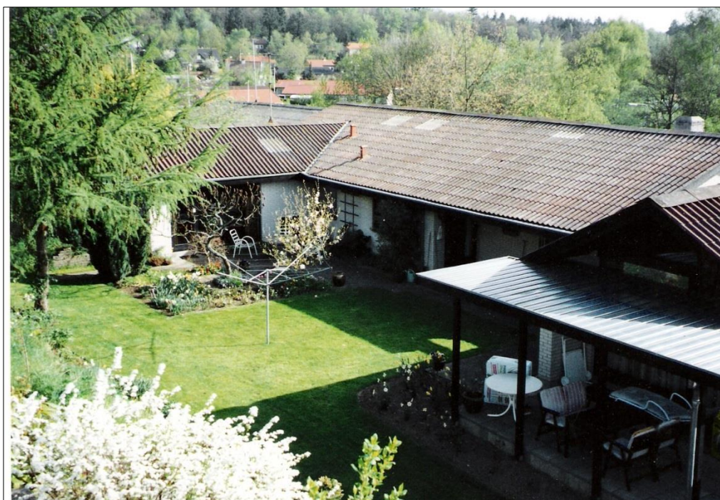
Huset ses fra skrænten bagved.
