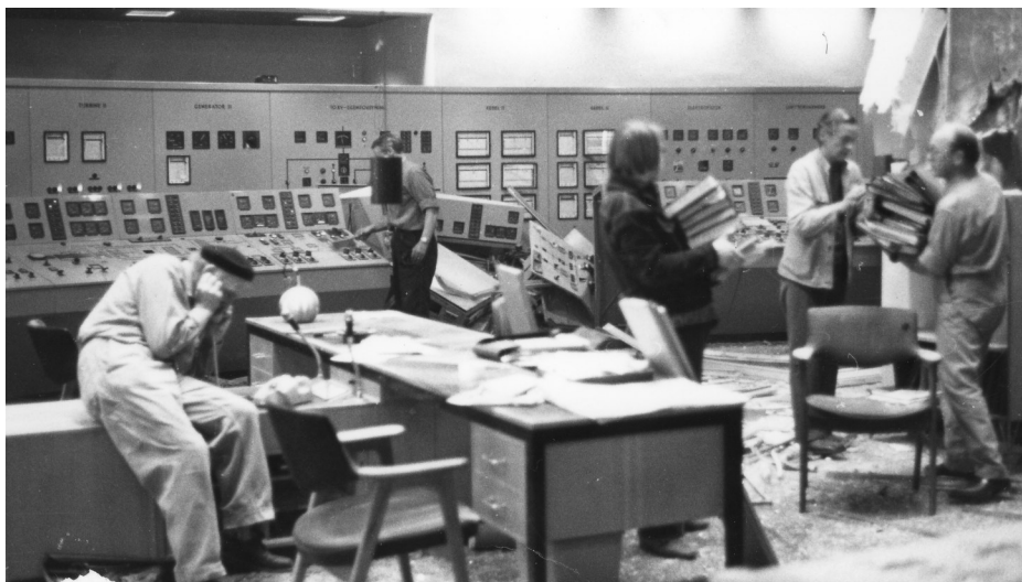
Det ødelagte kontrolrum
