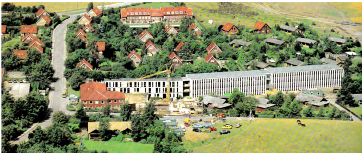
ELSAMs administrationsbygning 1979 med nyt kontrolrum under bygning
