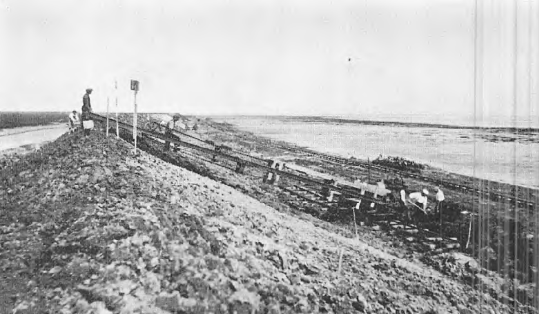
Dige på Rømø 1928. Maskinen benyttes til transport af græstørv.
