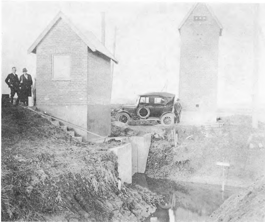
Væth enge september 1934. Ny pumpestation og transformator for elektrisk kraft.
