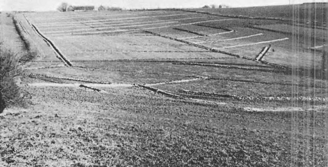
Dræningsarbejde under udførelse foråret 1934 i Pøel ved Malling. Drængrøfterne dækkes ved hjælp af muldsluffe.
