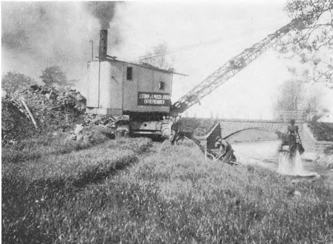
Uddybning af Halleby å i Holbæk amt 1931. Den moderne gravemaskine har larvefødder og er udstyret med grab. I baggrunden ses Ågerup bro.
