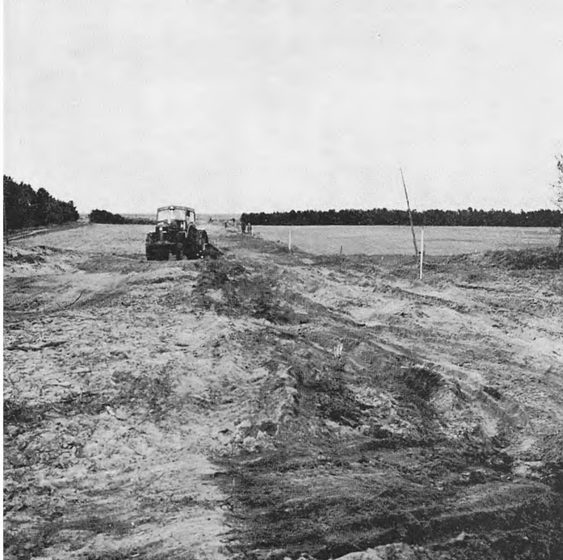
Buldozeren i arbejde ved anlæg af nye veje i Sdr. Vium hede 1955.
