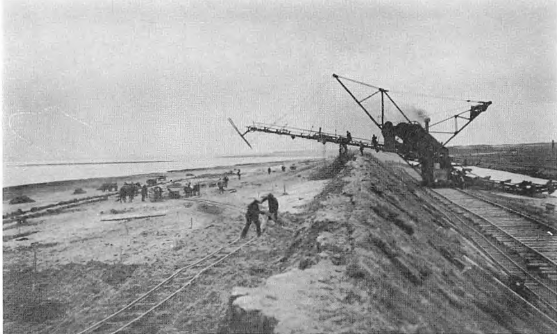
Vester Vedsted-Søndernæs havdige efteråret 1923. Reparationsarbejde efter stormfloden 30. august 1923.
