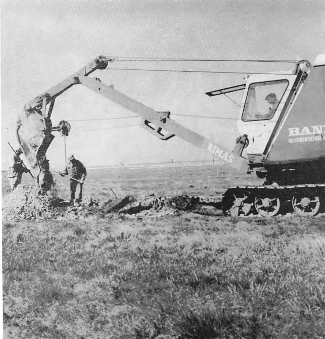
Maskingraving af drængrøfter på det inddæmmede areal under godset Gyldensteen ved Bogense maj 1961.
