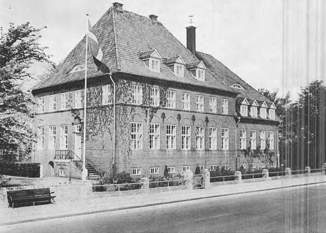
Hedeselskabets kontor i Tønder. Efter at staten havde overtaget den tidligere tyske landbrugsskolebygning, blev den stillet til rådighed for Hedeselskabet. Foto 1964.
