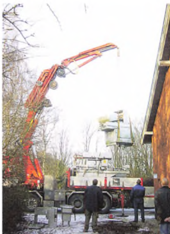
Flytningen af slagterisamlingen i Roskilde. Den meget omfattende samling rummer mange store og tunge genstande, som krævede kran for at kunne flyttes.
