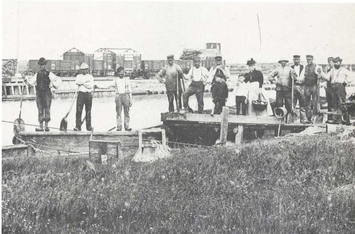
Trods et stigende antal arbejdspladser i industrien i løbet af 1800-årene, havde de fleste arbejde beskæftigelse ved håndværk, handel eller som her ved anlægsarbejde. Billedet viser arbejdere ved havneudvidelse ca. 1910.
