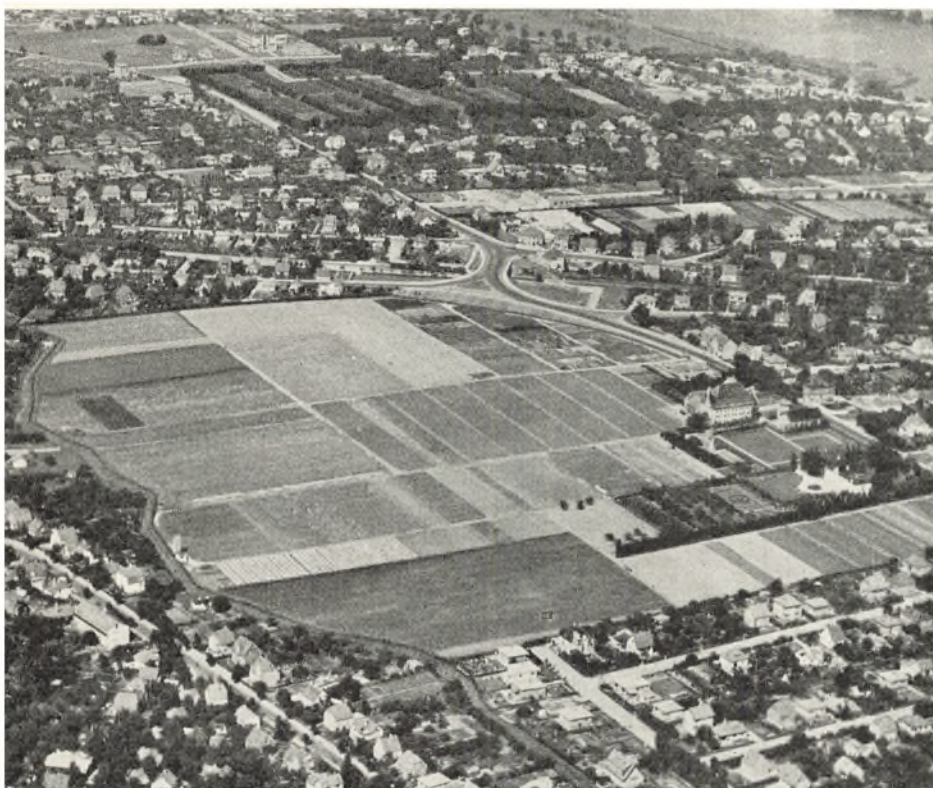
Flyverbillede af Dele af Gentofte og Gladsaxe Kommuner. Vangede. (Fot. 1936, Nowico). Vejene længst til venstre er Kiplings og Niels Finsens Alleer i Søborg, mens Vangedevej med Viadukten over Slangstrupbanen løber skraat igennem Billedets øverste Halvdel. Det aabne Terræn er Frøavlscentret paa Nordre Munkegaards Jorder. I de øverste Hjørner, henholdsvis til venstre og højre ses Dele af Nymose og Gentofte Sø.
