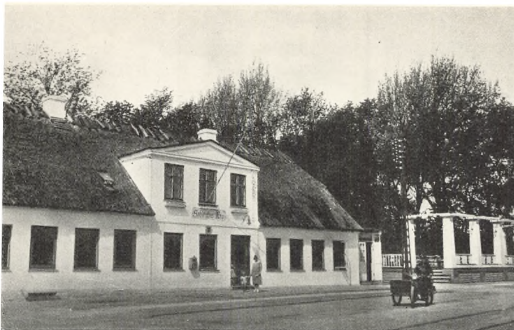
Øverst: Søborg Kro. (Fot. ca. 1935). I Midten: Frederiksborgvejen eller Søborg Hovedgade set fra Nord imod Søborghus Kro. (Fot. 1915, E. Nystrøm). Nederst: Samme Motiv som i Midten. (Fot. 1950, København Før og Nu, ved J. Sølvsten).
