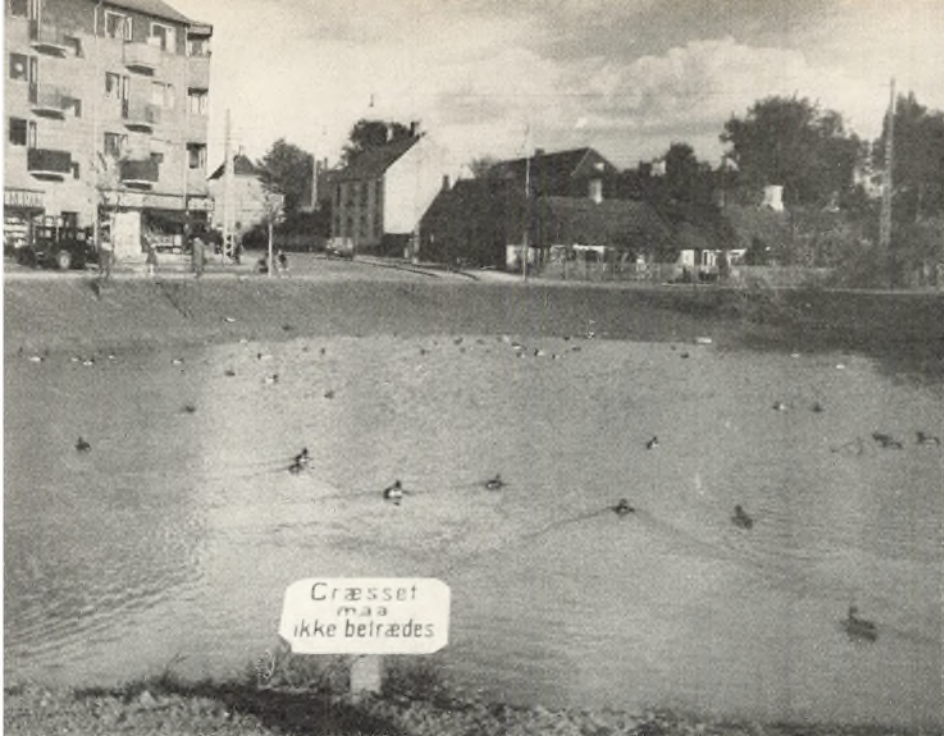
Øverst: Utterslev Gadekær. (Fot. 1937, Lebech). I Midten: Sokkelundsvej set i Retning mod Utterslev Torv. (Fot. 1950, København Før og Nu, ved J. Sølvsten). Nederst: Nordøstre Hjørne af Bebyggelsen omkring Genforeningsplads, set fra denne. (Fot. 1950, København Før og Nu, ved J. Sølvsten).
