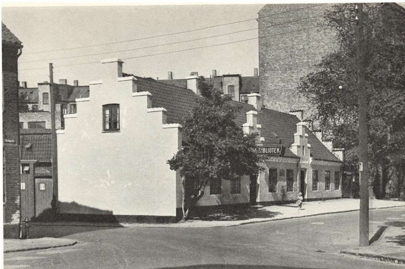
Paa Valby gamle Rytterskole, der nu benyttes som Kommunebibliotek, sidder stadig Sandstenstavlen med den kendte rimede Inskription, men iøvrigt er Skolebygningens Udseende ændret paa afgørende Maade, og den er længere end oprindelig. (Fot. 1933, Bymuseet).
