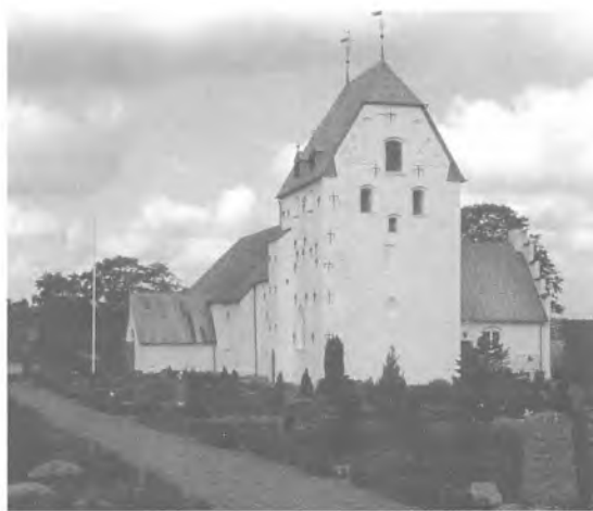
Fig. 7. Stepping Kirke, set fra sydøst. Tårnet var oprindeligt afsluttet med et helvalmet sadeltag, der endnu i middelalderen blev omdannet med halvgavle. Den østre er bevaret med en asymmetrisk blændingsdekoration bestående af rudestillede trappeblændinger, cirkelblændinger og et korset kors, hvis lighed med fynsk sengotik taler for, at gavlens murermester kom herfra. Foto: Thomas Bertelsen. 2004.
