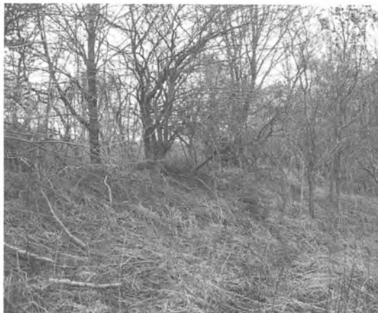
Fig. 3. Dæmningen ved den østlige ende af Ausødam. Toppen af dæmningen ligger 2-2,5 m over niveauet i de centrale dele af Ausødam.
