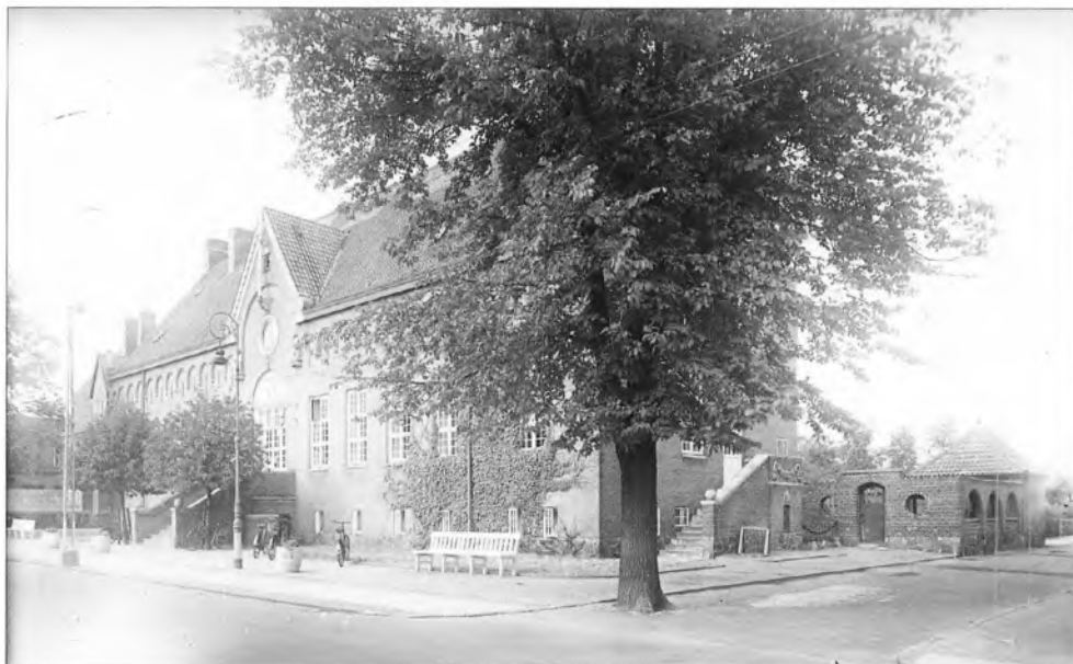
Silkeborg Bibliotek ca. 1930. Silkeborg opførte i årene 1918-1920 den kommunale bygning på Markedspladsen med varmtvandsbadeanstalt i kælderen, bibliotek i stueetagen og museum på 1. sal. Rasmus Randsløv Jensen var en af mændene bag etableringen af museet i bygningen.
