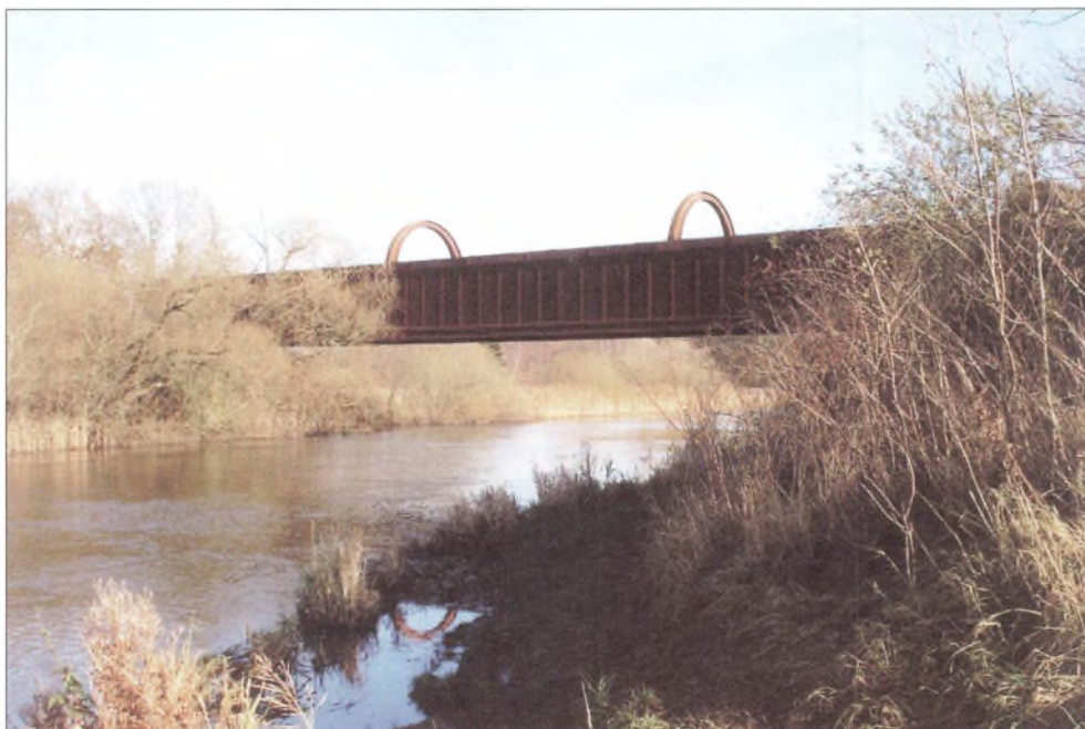
Den gamle jernbanebro over Gudenåen ved Langå er opført i 1862, sprængt i 1864 af preusserne. Den nye bro, opført i 1866, blev forsøgt sprængt 18. november 1943. I dag gangbro til natursti.
