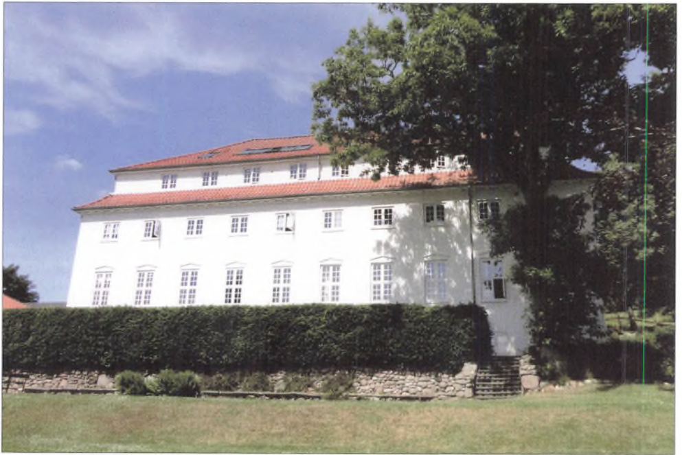
Facaden var 5 fag i 1925, siden er der bygget 5 fag til.
