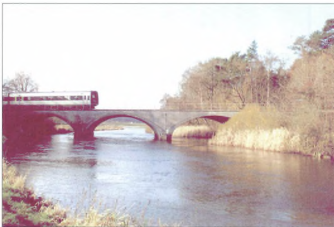
Den nye Langåbro, færdig i 1952.
