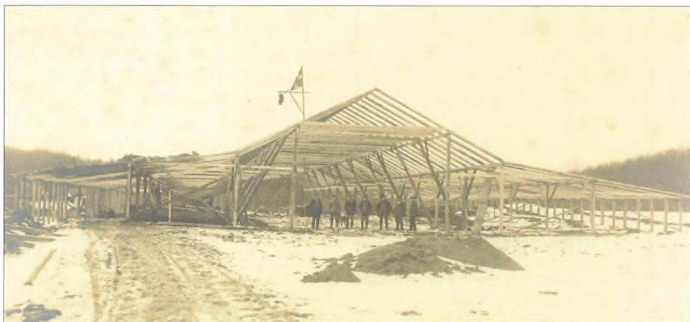
Billedet her er taget i forbindelse med rejsegildet på den nye ringovn, som blev bygget ca. 1915. Det var et stort fremskridt for teglværket at få en ringovn, som kunne øge produktion og indtjening. Det lavere træskelet, som ses på begge sider af hovedbygningen, er tørrelader.
