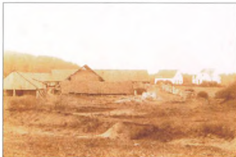
Foto af Hovedgaard Teglværk omkring år 1900. Yderst til højre ses det, som senere blev til formandsboligen. Teglværket var indtil ca. 1915 et højovnsteglværk. Den store bygning, som ligger mellem to lader, er højovnen.
