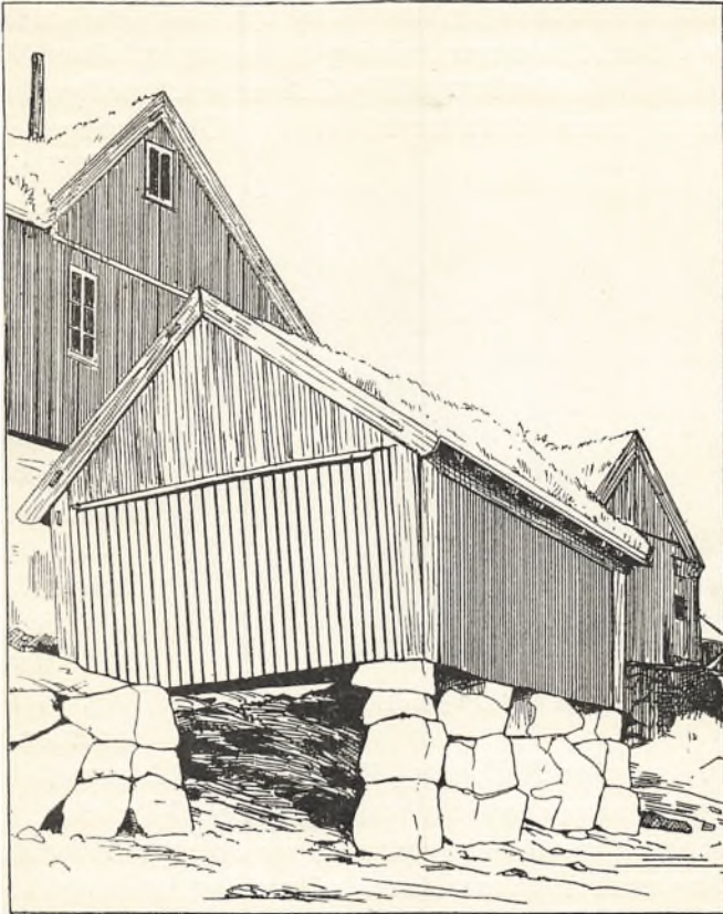
Fig. 70. „Kælde“ (Bur paa Stenstolper) i Torshavn paa Færøerne 1898. (Efter Daniel Bruun.)
