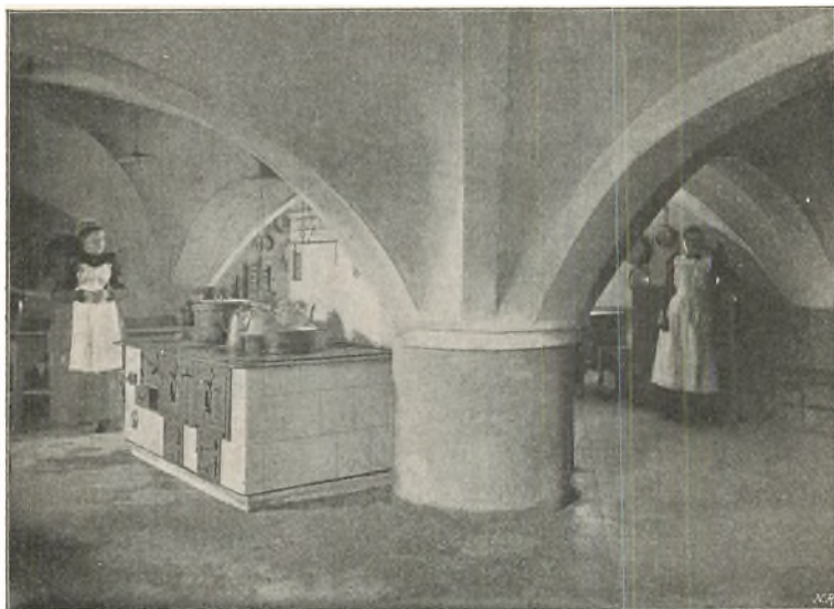
Fig. 138. Kælder paa Hesselager paa Fyn.
