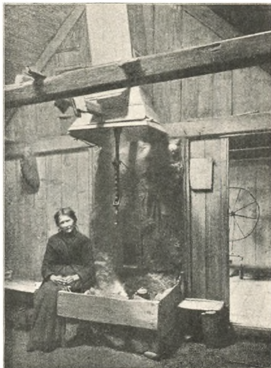
Fig. 38. Ildsted og „Esse“ (Røgleledning) af Træ i en færøisk Røgstue.
