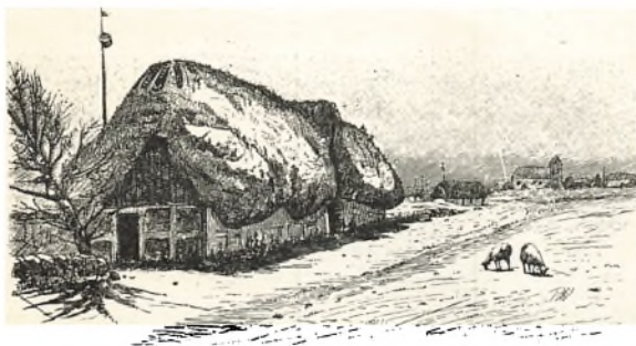
Fig. 15. Tag af Tang. Hus i Beyrum paa Læsø. (Efter Tegning af R. Bissen.)
