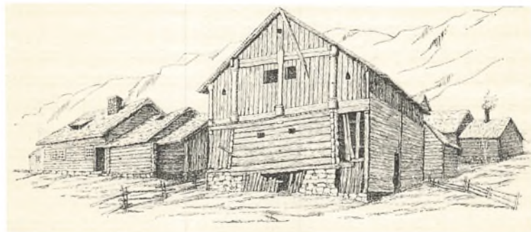
Fig. 80. Gaarden Finne i Vossevangen. Tilhøjre „Loftet“, midtvejs „Ildhus“ med Lyrehul i Taget, tilvenstre nyere Stuebygning med Stenskorsten, (Efter „Kunst og Haandværk“.)
