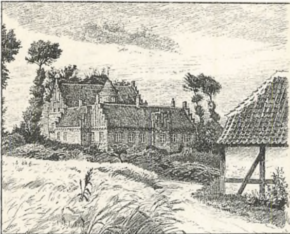
Fig. 51. Rygaard paa Fyn. Opført i det 16de Aarhundrede i en Sump paa nedrammede Pæle. (Efter Tegning af Tom Petersen 1887.)
