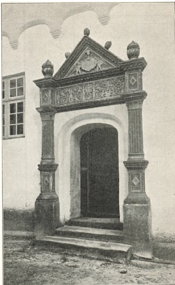
Fig. 91. Den oprindelige Egetræs-Dør, forsynet med Bom, i Trappetaarnet paa Nakkebølle (Fyn). Opført 1559—63. (Efter Fotograf af Kr. Hude.)
