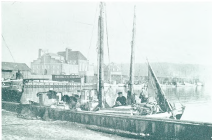
Aabenraa gamle Havn med Højspændingsværket i Baggrunden
