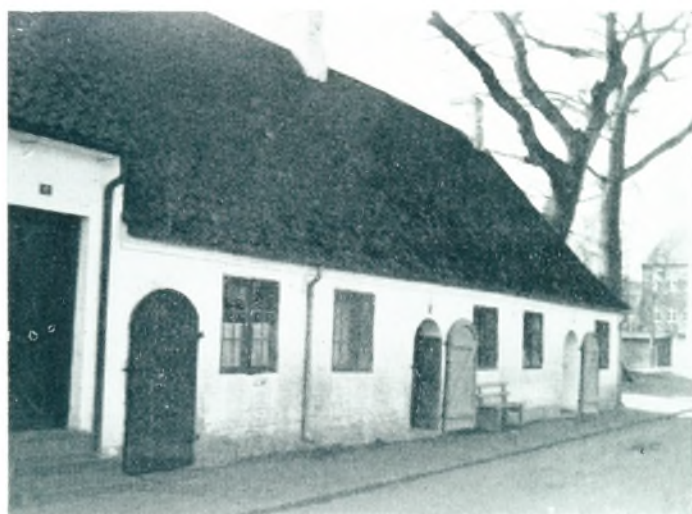
Det saakaldte Hospital ved den gl. Skole
