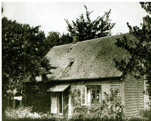
Huset fotograferet i 1912. Det karakteristiske spån-tag var almindeligt på tidens sommervillaer og ses også benyttet på fiskernes nyere huse i Hornbæk. Nederst i.v. et portræt af Bygherren Oberst Werner Frederik Abrahamson (1822-1911).
