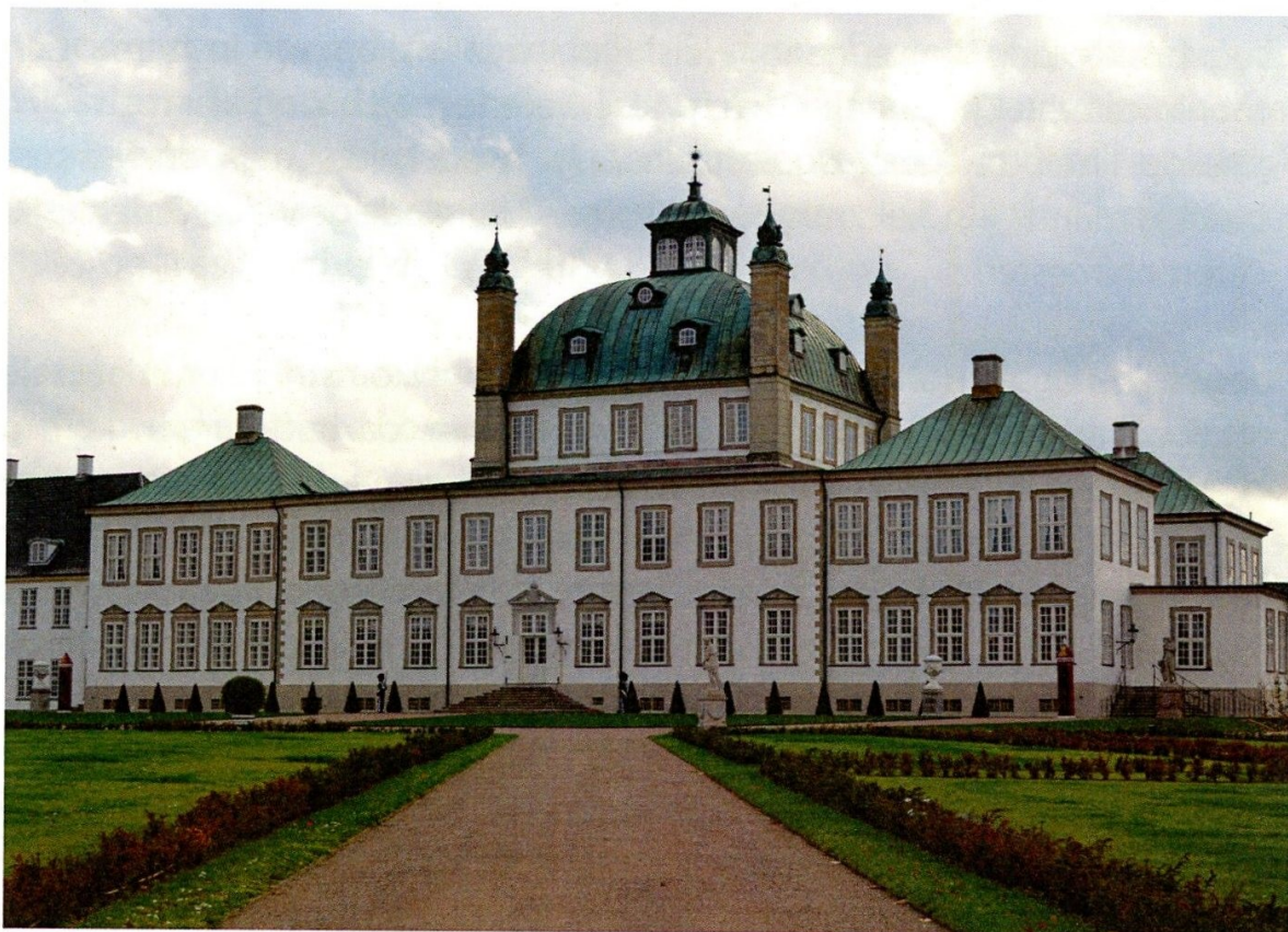
Fredensborg slot set fra det nyanlagte parterre. Foto Flemming Jappsen
