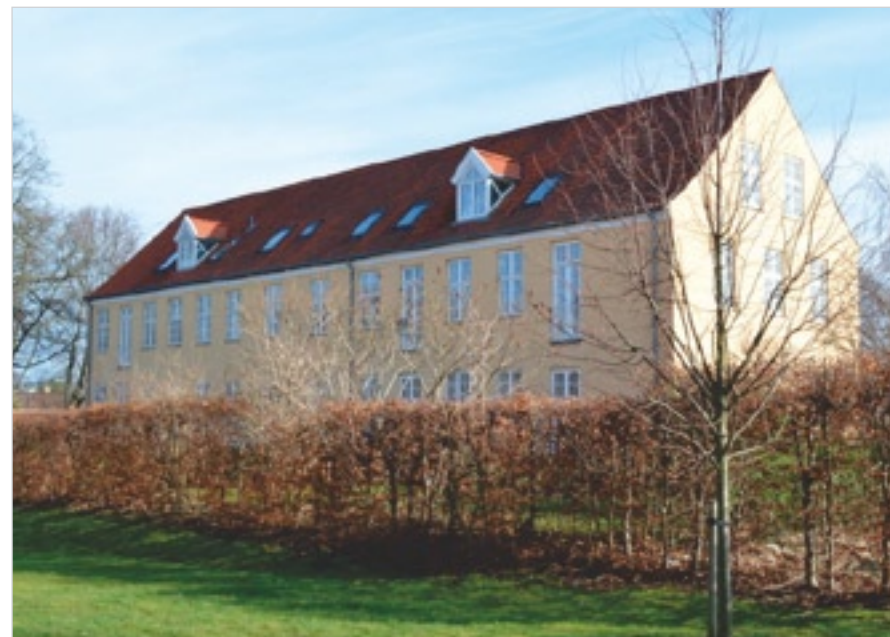
Det tidligere rådhus ved Brønsholmsdal. De i teksten nævnte tilbygninger blev nedrevet efter flytning til det nuværende Rådhus.
