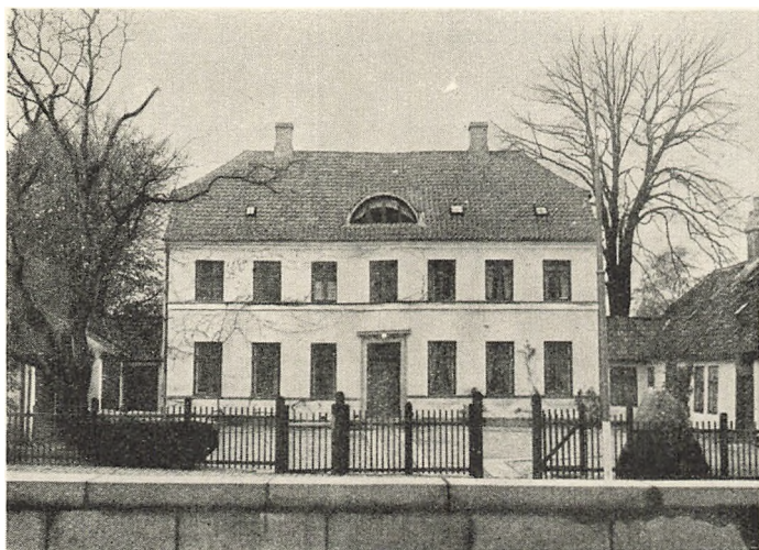
Rektorboligen ved Katedralskolen i Roskilde er bygget 1821 af P. Malling. Her er Klassicismen bragt paa ganske enkelt Form, kun Døren beskeden fremhævet. Huset er ligesom gjort højere ved Gesimsbaandet, der er løftet op under Førstesalens Vinduer.
