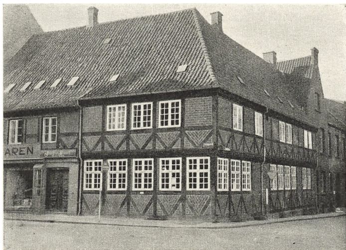
„Czarens Hus“ i Nykøbing F. er et kønt Hjørnehus, opført af Bindingsværk ca. 1700. Huset er stærkt restaureret.
