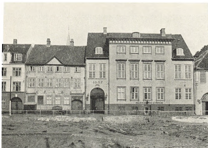
Strandgade 91, den Galschiøtt-Kierboeske Gaard, opført 1580, ombygget 1637, og Strandgade 93, det Classenske Palæ er bygget 1791–93, mulig efter Harsdorffs Tegning.
