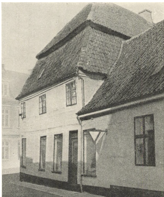
„Wichmanns Gaard“ i Sakskøbing er et kønt Hjørnehus, opført af Bindingsværk i det 18. Aarh. Bemærkelsesværdigt er Mansarttaget.
