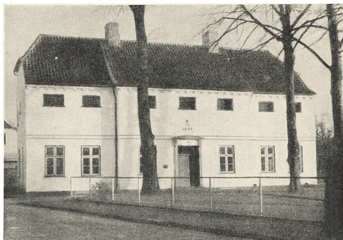
Løve Herreds Tinghus i Høng, opført i klassicistisk Stil af C. F. Hansen i 1838, et nøgternt, enkelt Hus med svagt fremspringende trefags Midtparti. Under Tagskægget en afsluttende Tandsnitsgesims. De øverste Vinduer fortæller om Arrester.
