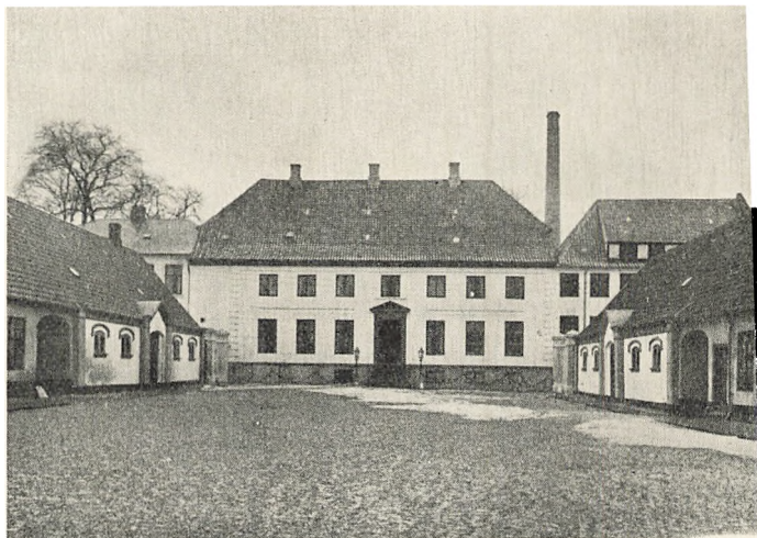
Brede Klædefabriks Hovedbygning og Direktørbolig er opført 1795 af Arkitekten Lillie i Klassicismens mest fordringsløse Manér, men ikke uden Værdighed.
