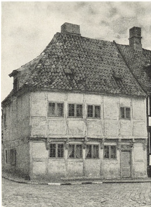
Strandgade 27 er Helsingørs ældste Bindingsværkshus, bygget 1577. Knægte og Fyldholter er rigt udskaarne.
