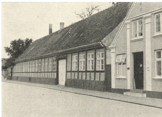
Amtmandsboligen i Rønne er et pynteligt Bindingsværkshus i een Etage, opført ca. 1800.
