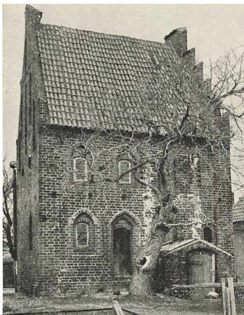
Den saakaldte „gamle Latinske“ i Præstegade i Kalundborg er et middelalderligt Stenhus, højt og kort med Blændingsgavle og spidsbuede Vinduer; det har Gotikens stejle Rejsning. Maaske Danmarks ældste Borgerhus.
