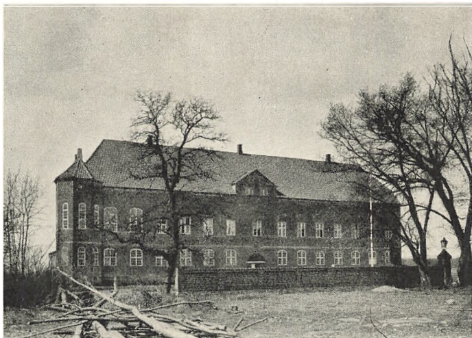
Den mægtige Portfløj paa Ravnstrup fra 1590erne er nu ene tilbage af det tidligere store Herregaardsanlæg. Læg Mærke til det ualmindelig høje øvre Stokværk, oprindeligt een stor Sal, Dansesalen. Det meget ordensbestemte Hus savner nu bl. a. sine høje Gavle.
