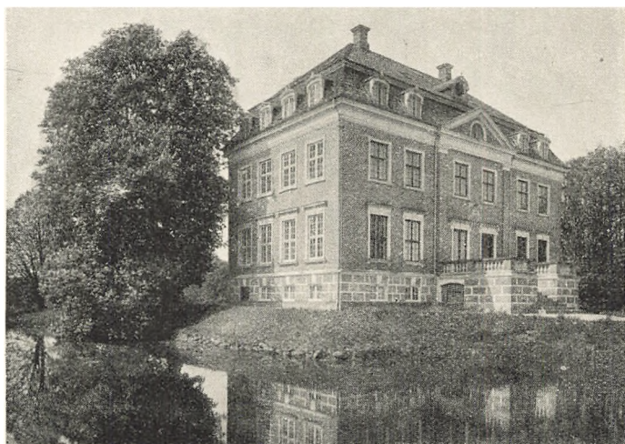
Hovedbygningen paa Christianssæde er opført 1690 i nederlandsk Barokstil. I 1730 foretoges en Ombygning. En haardhændet Restaurering i 1883 berøvede Havefacaden dens oprindelige Udseende, idet de to karnapagtige Udbygninger erstattedes af een Midtrisalit.
