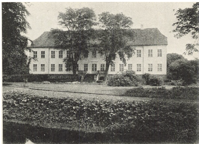
Kragerupgaards nuværende trefløjede Hovedbygning er opført 1801—02 i klassicistisk Stil med fugede Side- og Midtpartier. I Bygningen er benyttet Murværk fra den tidligere Hovedbygning.
