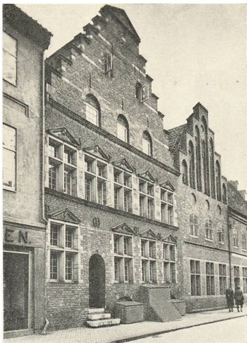
Det prægtige Stenhus i Helsingør, Stengade 76, fra 1579 er en meget fornem borgerlig Murstensbygning. Gavlen, der vender mod Gaden, er paa gotisk Vis aftrappet, medens Facaden nedentil er et typisk Renaissancearbejde i nederlandsk Manér, med nøje Tilknytning til Kronborgs Arkitektur.
