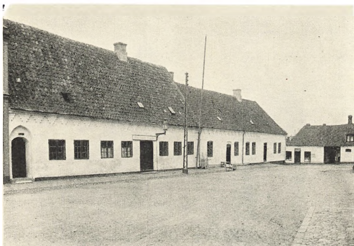
Borgmester Mogens Tuesens Boder før Restaureringen.
