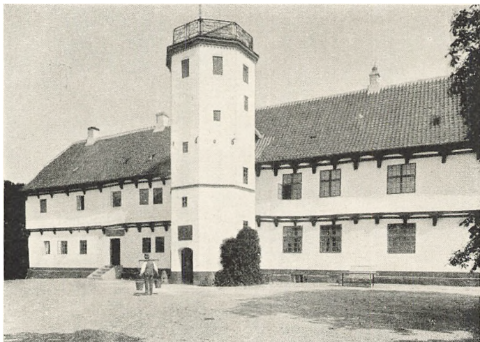
Rudbjærggaard, opført 1600—1606, er en typisk Renaissancegaard, bygget af Bindingsværk og med muret, ottekantede Trappetaarn.
