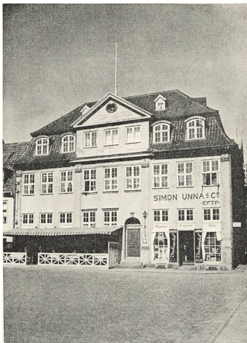
Strandgade 75, Barokhus i den alvorlige Manér opført ca. 1740. Facaden har et svagt fremspringende Midtparti, der skyder sig op over Gesimsen i trefags Kvist med Fronton. Stue- og Tagetage ombygget.
