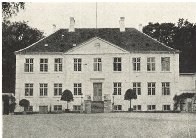
Petersgaard er opført 1776—80 for Storkøbmanden Peter Johansen. Hovedbygningen er et sobert Hus i klassicistisk Stil med pilastersmykkede Facader og Frontoner over Midtpartierne og hele den ordensbetonede elegante Fremtræden, der er Tiden og Stilen egen.
