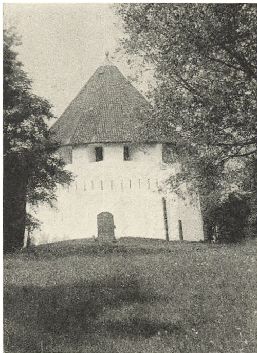
Det gamle Kastel i Rønne er opført 1689. Det er et lavt, rundt Taarn med vældigt tykke Mure med Stræbepiller til Afstivning. Under Taget løber en Række skydeskaarlignende Vinduesaabninger.
