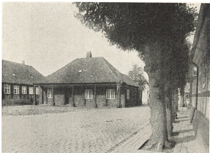
Hovedvagten i Rønne opført 1743—44. Vagthuse, „corps de garde“, af denne Type med fremspringende Tag, baaret af Søjler, blev opført overalt i Landet ved militære Anlæg i det 18. Aarh.
