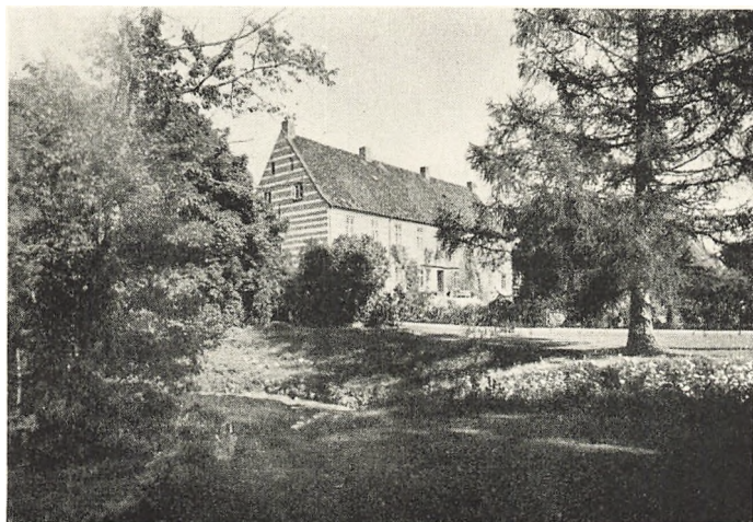
Beldringe ved Præstø er opført 1561, oprindelig som et trefløjet Anlæg med Trappetaarne. Sideløje og Taarne er forlængst borte, men man kan endnu glæde sig over Hovedhuset med de høje Gavle og de sribede Mure, lagdelt af Tegl og Kridt. Dele af Voldgraven er bevaret.
