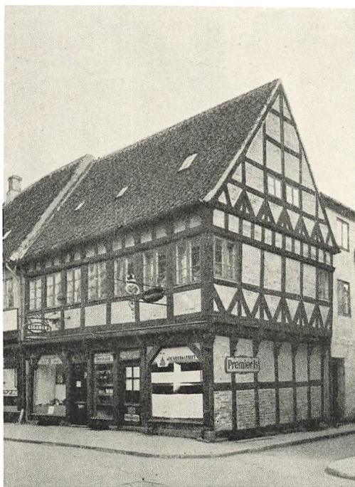
Stengade 20, Bindingsværkshus fra ca. 1600. Nedre Stokværk ombygget med Bibeholdelse af Faginddelingen. Læg Mærke til den festlige Tømmerkonstruktion i Gavlen.
