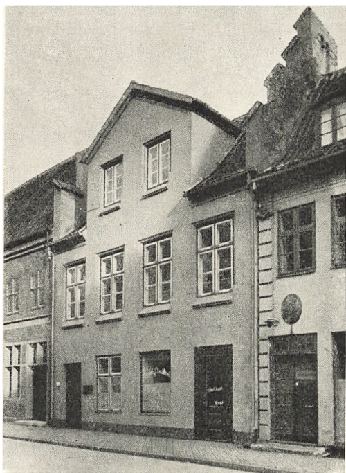
Stengade 70 er opført ca. 1500, men er ombygget i det 18. Aarh. Endnu ses de to blændingsprydede, kamtakkede Gavle.
