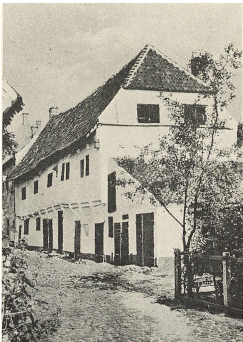
Gammelt Pakhus ved Dronningestræde og Søndergade 28.
