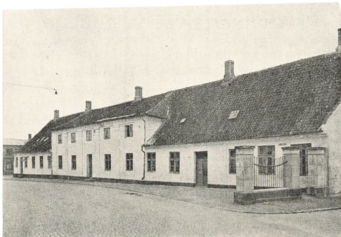
Brænderigaarden i Slagelse for Enden af Slotsgade, en langstrakt Bygning, efter gammel Skik med højt Midtparti, her prydet med kannelerede Pilastre.
