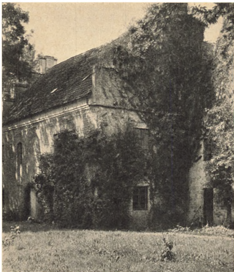
Søndre Tjele. Løvenbalkernes Stenhus, set fra Haven.
