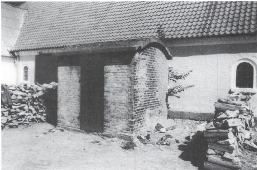
Fig. 26. Motorhus fra starten af 1900'tallet og frem til 2. Verdenskrig blev der installeret stationære motorer på mange gårde. Det krævede, at der blev bygget brandsikre motorhuse. De blev ofte bygget hvor hestegangen tidligere havde været placeret. Fotografi: Skov- og Naturstyrelsen.
