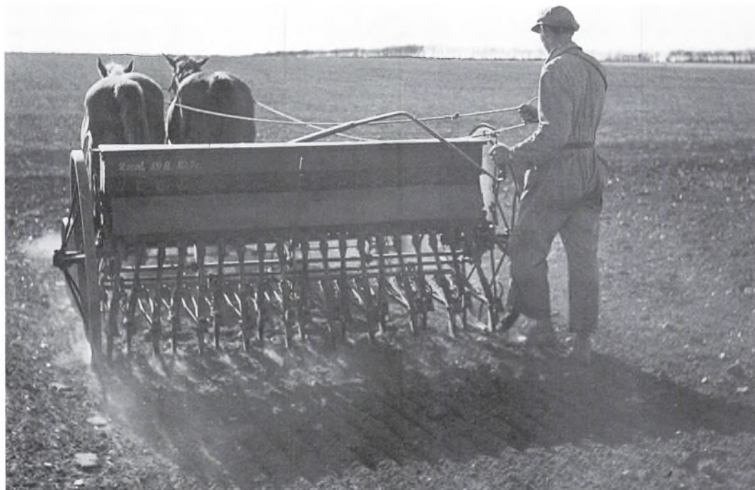
Fig. 14. Med radsåmaskinen blev sæden lagt direkte ned i jorden, derved kunne kernerne spredes med den rigtige afstand og lægges i den rigtige dybde. Foto fra Landbrugsrådet, 1943.
