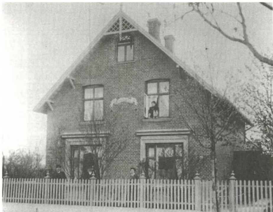
Typisk, færdigt hus. Hartmanns Allé, hvor grundstenen blev lagt
