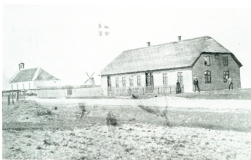
Agger Skole før Restaurationen.
