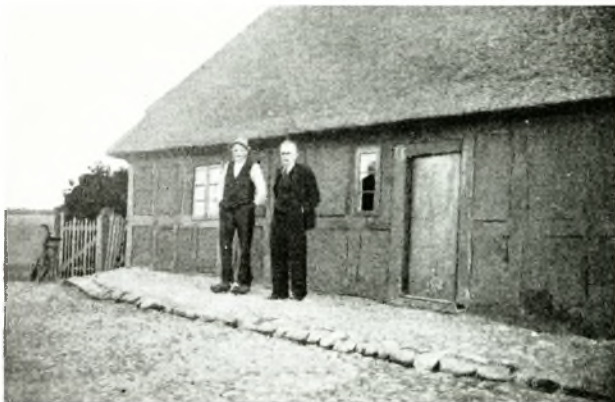
Thomas Sørensen og Niels Chr Nielsen foran det gamle Stuehus i Agerskov, bygget 1829. — Der er ingen Vinduer tilhøre for Indgangsdøren, her var de gamle Alkover indbygget i Dagligstuen. Fot. L. 1944.
