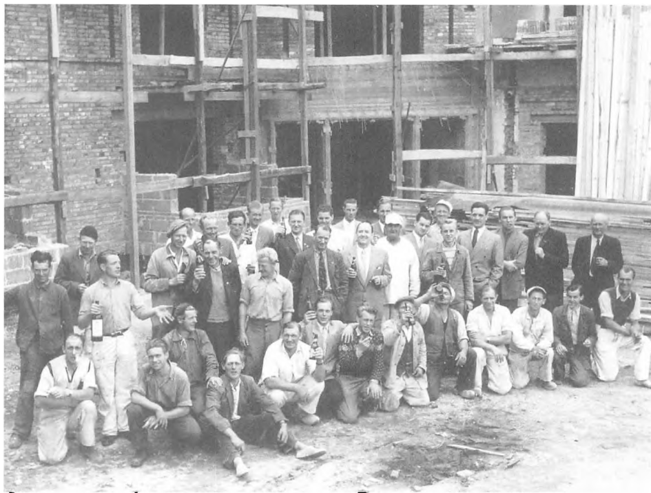
Ud for den senere hovedindgang til hotellet, har alle byggearbejderne og håndværkerne samlet sig sammen med bygherren, Oscar Pedersen, der ses lidt til venstre for indgangen. Anledning er formentlig rejsegildet i 1951.
