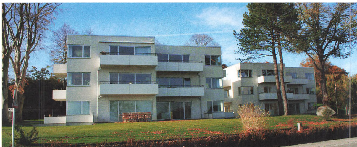
Som det fremgår af disse to billeder, er den gamle parklignende have til Abildgaards villa nu bebygget med to modernistiske "punkthuse" indrettet til ejerlejligheder. Ved byggeriets planlægning lagde man vægt på, at så meget som muligt af det oprindelige haveanlæg skulle bevares. Realiteten er imidlertid, at kun enkelte opstammede træer har overlevet. (Fotos: Oktober 2008)
