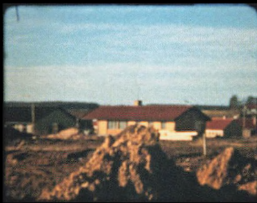
Den 18. september 1966: Opgravningen til kloakrør begynder:
