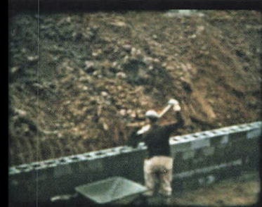
Den 18. marts 1967: Støbningen af vor kelder er gået i gang.
